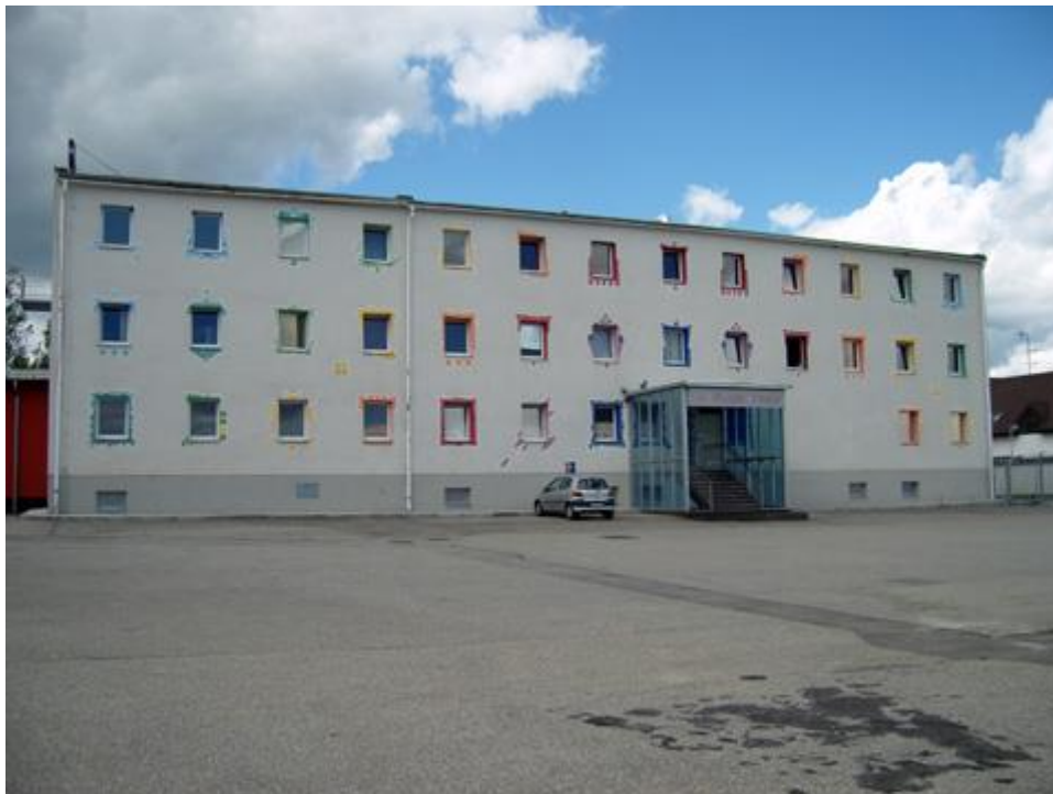
Příloha č. 18: Budova rPS v Dolním Dvořišti
