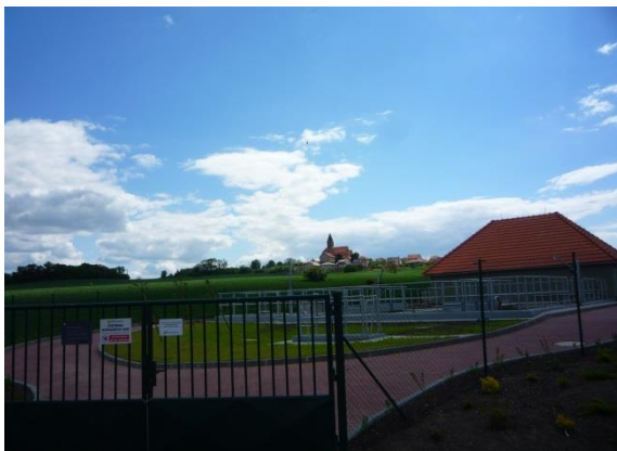
Čistírna odpadních vod Zaječí
