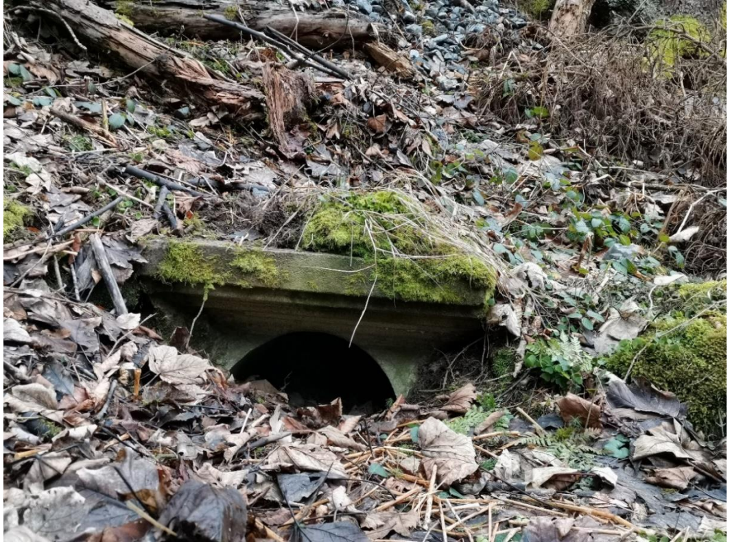
Obrázek č. 40 - Trubní propustek s betonovým čelem na lesní cestě KO402
