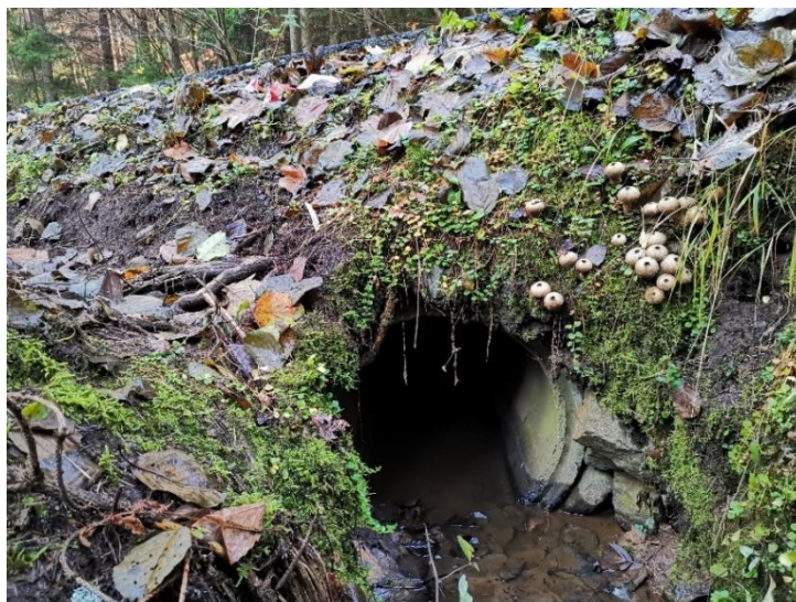
Obrázek č. 9 - Trubní propustek na lesní cestě KO402
