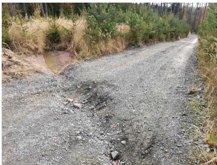
Obrázek č. 10 - Nezpevněná svodnice vody na návrhové svážnici KO418-1
