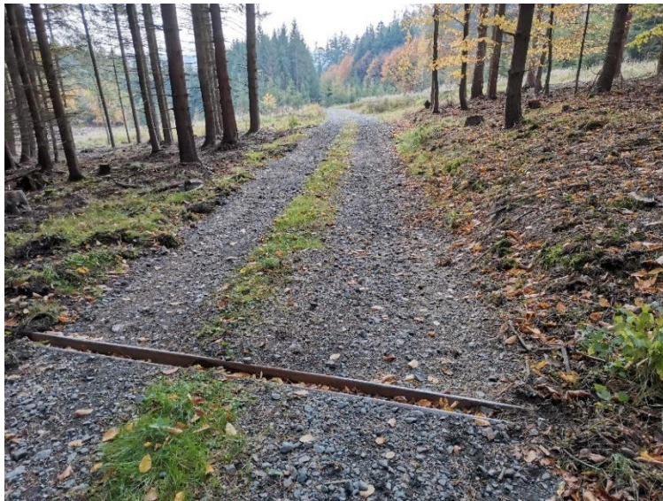
Obrázek č. 11 - Ocelová svodnice vody na návrhové svážnici KO418-1
