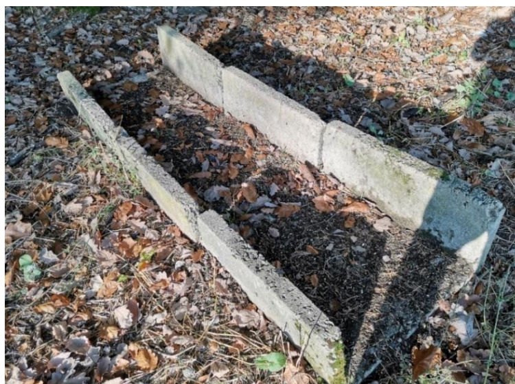
Obrázek č. 19- Betonové koryto
