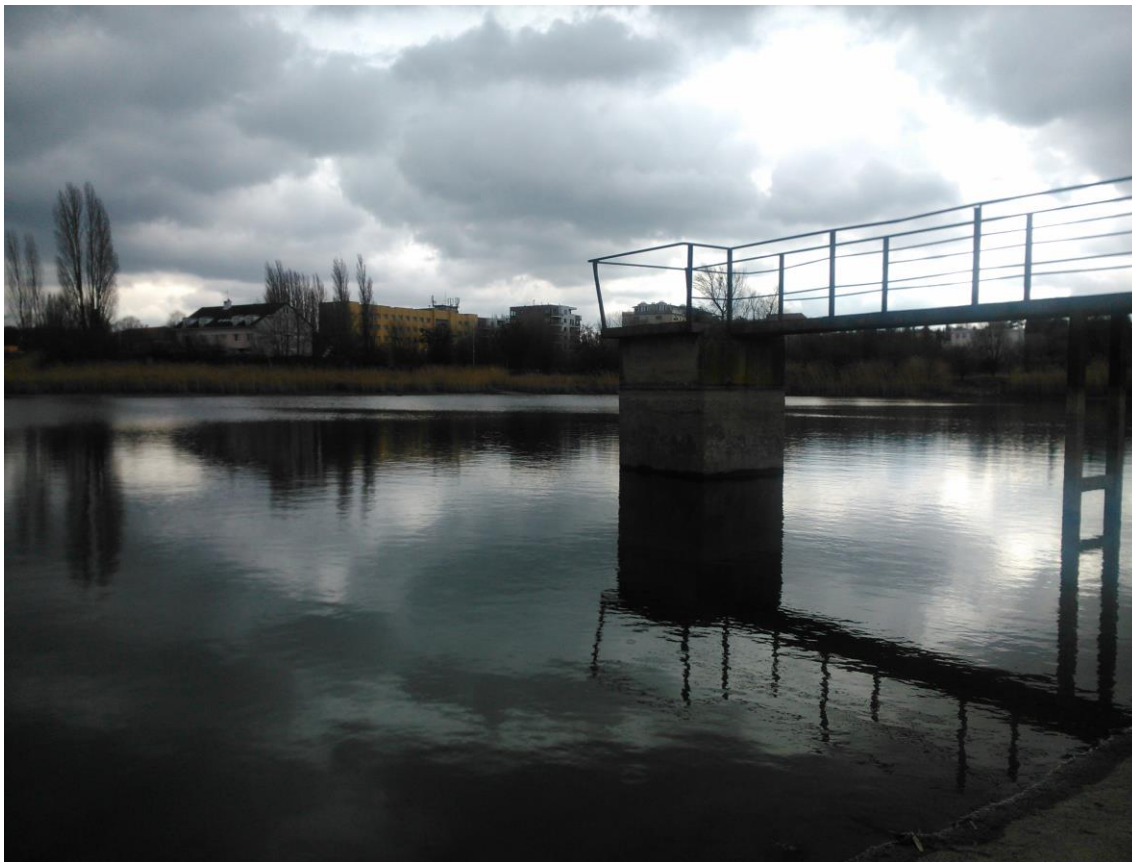
Obrázok 11 - Fotografia výpustného zariadenia
