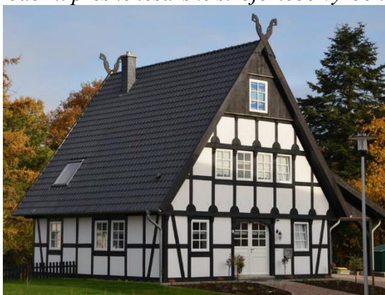
Obr. 4 Moderní hrázděná stavba s viditelnou nosnou konstrukcí ( www.dlk-melle.de )
