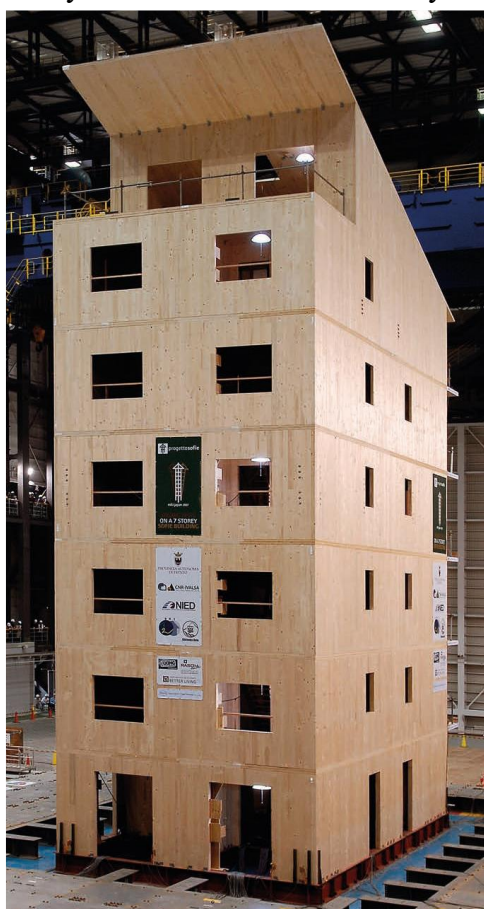
Obr. 3 Vícepodlažní dům z CLT panelů (XLAM Dolomiti, 2019)
