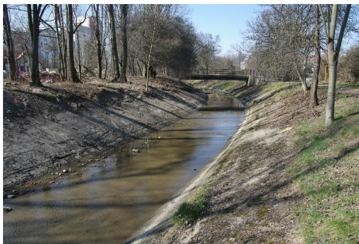
Obr. 14: Rokytky před revitalizací byla v podstatě jen betonový kanál. (zdroj: archiv OCP MHMP)
