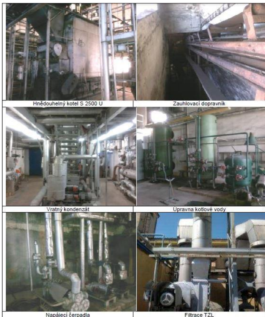
Obrázek 4 Fotodokumentace původní kotelny s příslušenstvím [4]
