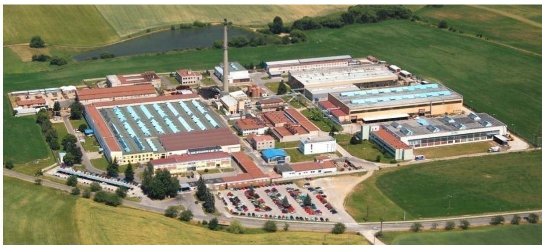
Obrázek 1 Pohled na areál společnosti PBS Velká Bíteš [fotodokumentace PBS VB]
