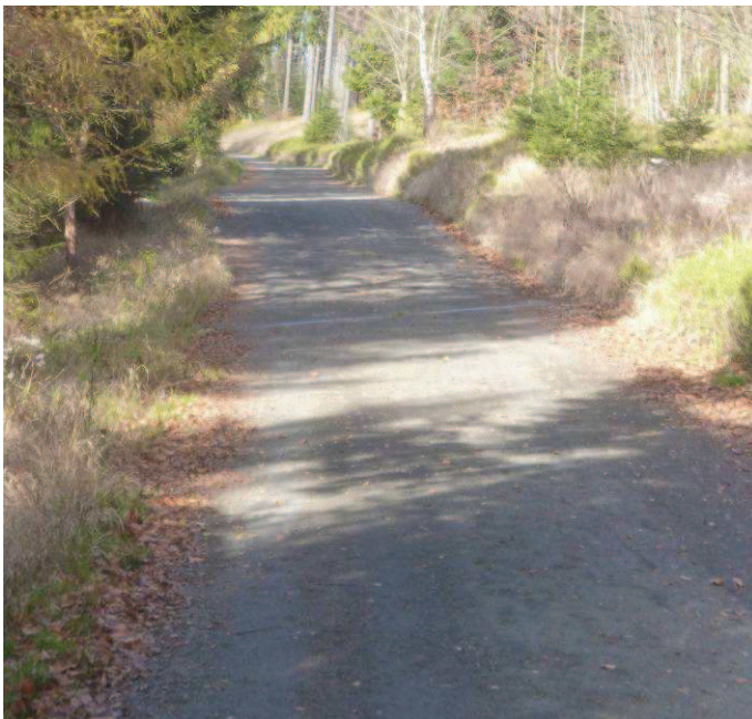
Příloha 4: Lesní cesta 2L Nad Myslivnou po rekonstrukci.
