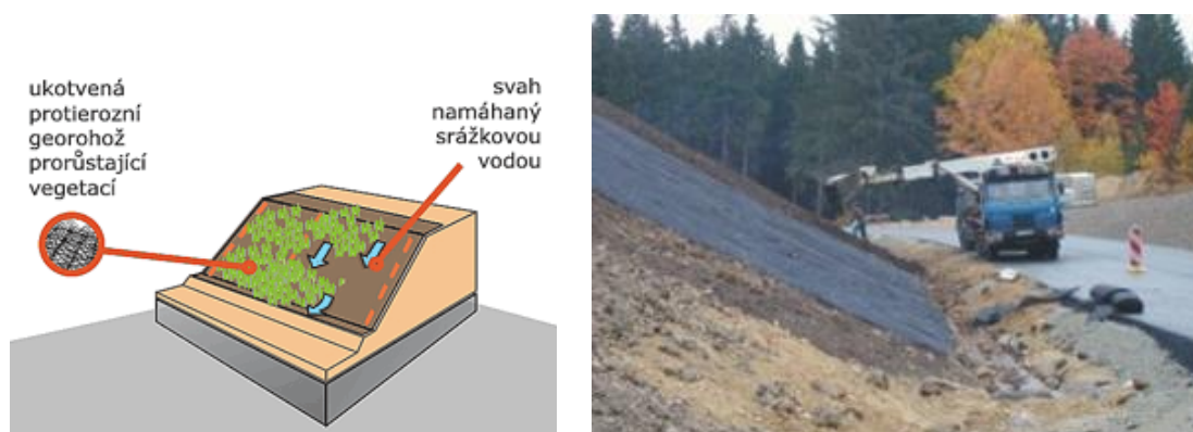
Obrázek 6: Aplikace georohože
