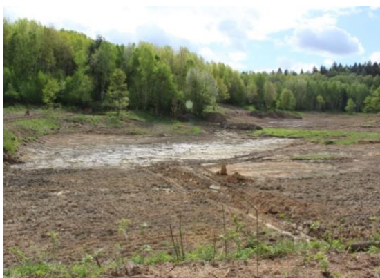
Obrázek 16 (vlevo): Průběh výstavby projektu Vodní nádrže Na cvičáku
