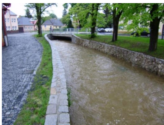
Obrázek 17: Stav koryta řeky Zubřiny po opravě a zkapacitnění Zdroj: (POVODÍ VLTAVY, 2021)
