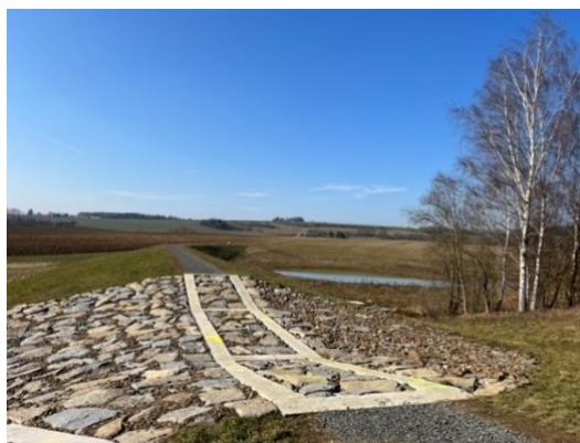
Obrázek 19: Současný stav projektu Suchá nádrž Týnské předměstí Zdroj: (pořízeno autorem)
