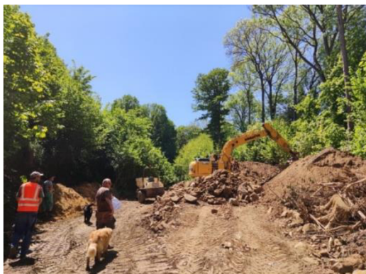
Obrázek 18 (vlevo): Průběh výstavby protierozní rokle Zdroj: (město Domažlice – nepublikováno)
