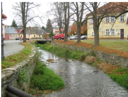
Obrázek 16 (vlevo): Stav koryta řeky Zubřiny před opravou a zkapacitněním Zdroj: (POVODÍ VLTAVY, nedatováno)
