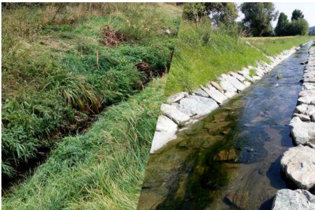
Obrázek 13: Průběh revitalizace vodního toku
