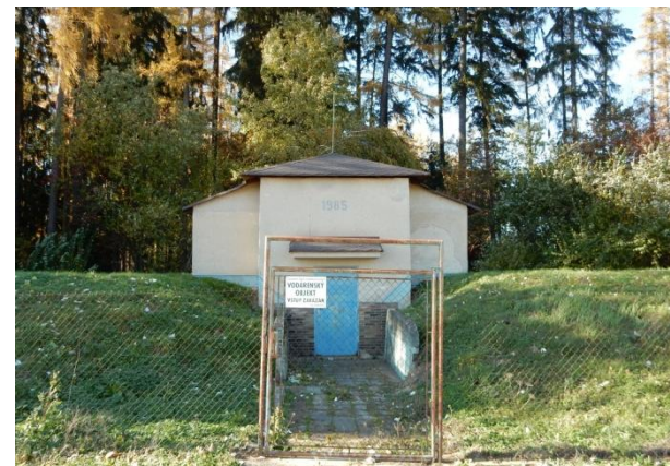
Příloha 32: Vodojem (zdroj vlastní)
