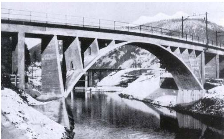
Obr. 15 – Landquart River Bridge, Klosters, Švýcarsko – pohled na dostavěný most
