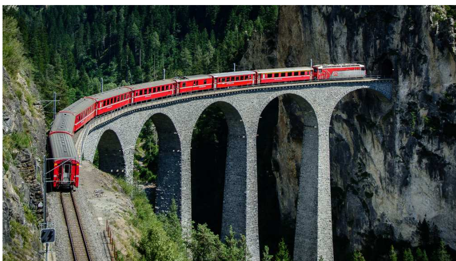
Obr. 9 – Landwasser Viaduct, kanton Graubünden, Švýcarsko
