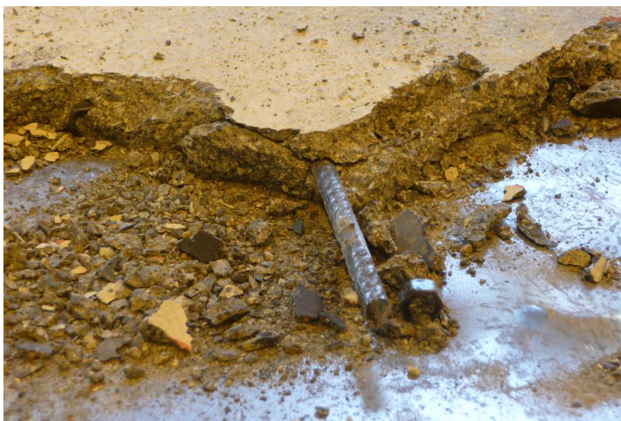
Obr. 144 – Detail výztuže z opěry a spřahovacího prvku během bourání
