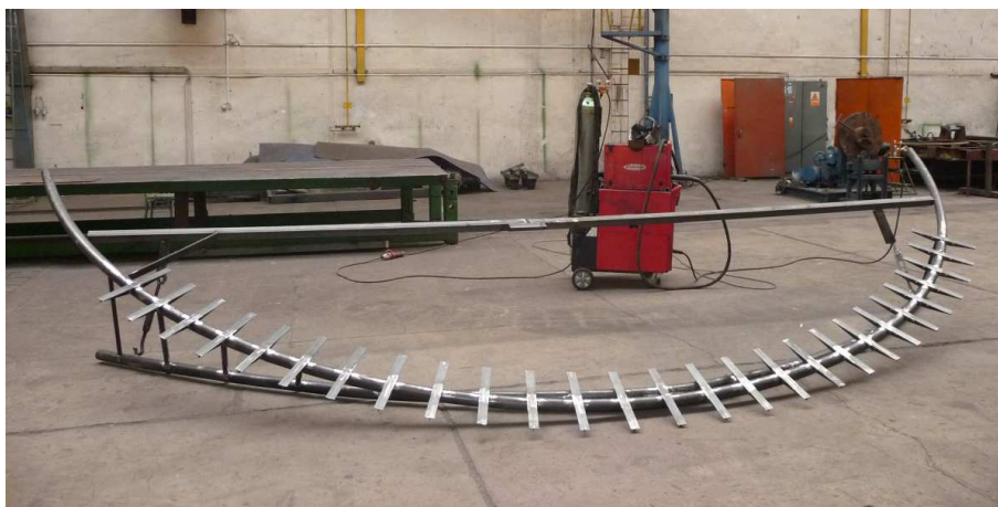
Obr. 130 – Ocelová konstrukce před navařením koncových příčníků, kotevních plechů oblouku a plechů ztraceného bednění
