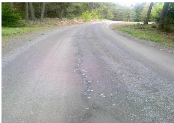
Obrázek 96: Lesní cesta „Dlouhý palouk“ Porucha – eroze (Veronika Rusová 2017)
