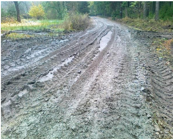
Obrázek 10: Závady na vozovkách se štěrkovým povrchem (Klč, 2005)
