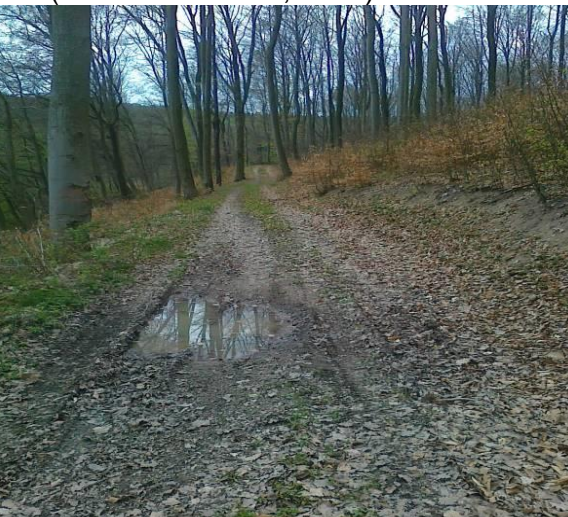
Obrázek 44,45: Lesní cesta Lysá Lokální porucha - neúnosné podloží, zanedbaná údržba (Veronika Rusová, 2017)
