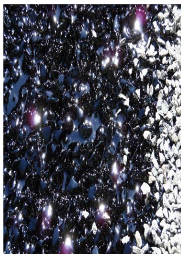
Obrázek 4,5,6,7,8,9: Živičný nátěr – průběh opravy (Veronika Rusová, 2015)
