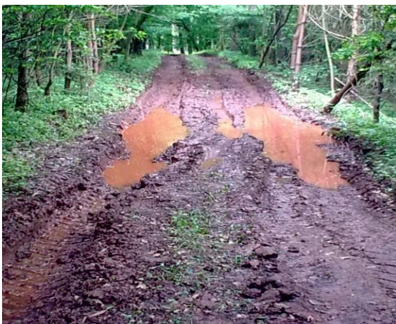
Obrázek 11-14: Závady na vozovkách se štěrkovým povrchem (Veronika Rusová, 2017)
