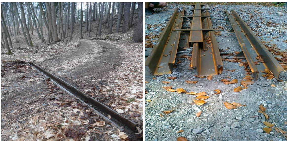
Obrázek 33,34: Svodnice Reverdo (Veronika Rusová, 2017)
