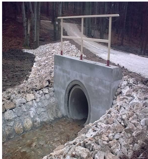
Obrázek 36: Propustek DN1200 (Veronika Rusová, 2013)
