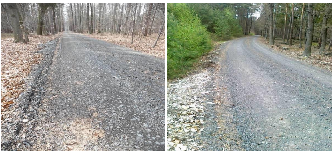
Obrázek 67, 68: Lesní cesta „Kroučovská“ Lokální porucha – propadlé koleje (neúnosné podloží) (Veronika Rusová 2017)
