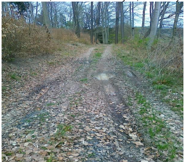
Obrázek 44,45: Lesní cesta Lysá Lokální porucha - neúnosné podloží, zanedbaná údržba (Veronika Rusová, 2017)
