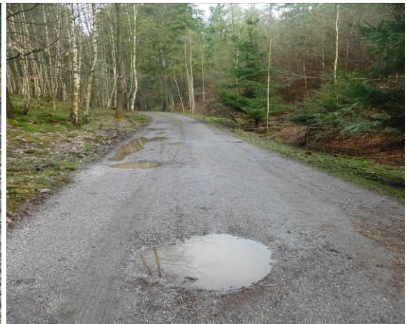
Obrázek 10: Závady na vozovkách se štěrkovým povrchem (Klč, 2005)
