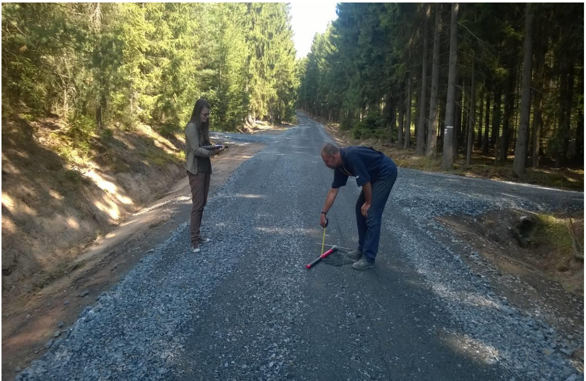
Obrázek 18: Kontrola vrstev štěrkové vozovky (Veronika Rusová, 2015)
