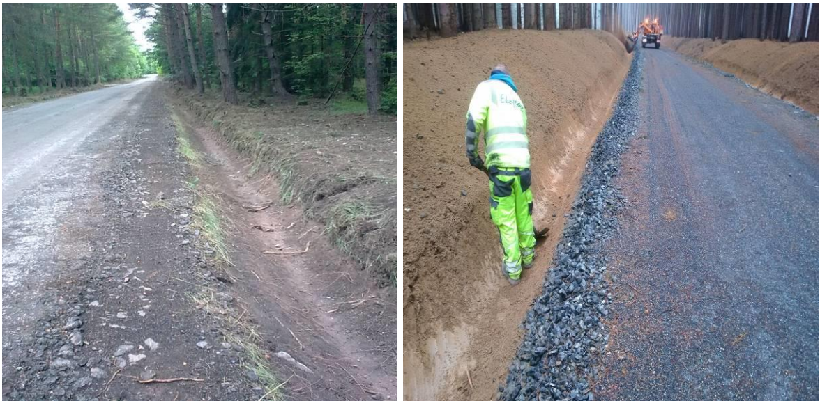
Obrázek 29,30: Příkop čištěný příkopovou frézou (Veronika Rusová, 2015; Lesy ČR, s.p., 2017)
