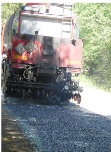
Obrázek 4,5,6,7,8,9: Živičný nátěr – průběh opravy (Veronika Rusová, 2015)
