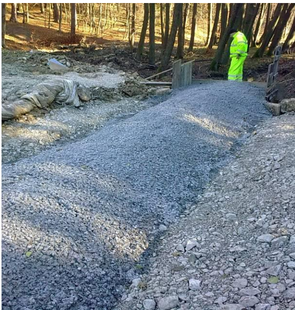
Obrázek 35: Obetonování spojů, propustek DN1200 (Veronika Rusová, 2013)
