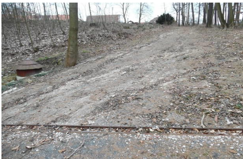
Obrázek 56: Lesní cesta „Z Kroučové do oddělení 636“ Porucha – eroze (Veronika Rusová 2017)
