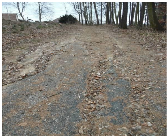
Obrázek 11-14: Závady na vozovkách se štěrkovým povrchem (Veronika Rusová, 2017)
