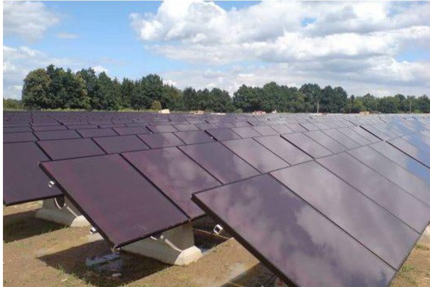
Obrázok 7: Amorfné FV panely súčasťou „solárnej farmy“ [13]
