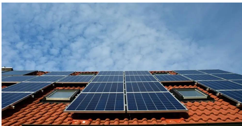
Obrázok 6: Polykryštalické FV panely na streche [13]
