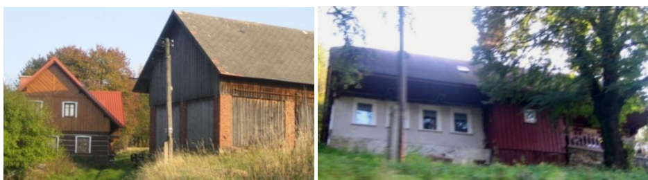
Obr. č. 57 a 58: Další příklad špatného provedení rohu roubené chalupy na obrázku nalevo. Na druhé fotografii je stavení, které má jak zděnou část, tak i roubenou, u které se nachází násep, která je vyskládaná z kamene. (foto: autor, 2011)
