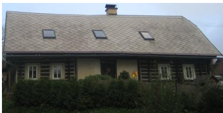
Obr. č. 207: Roubená chalupa, na které je vidět trojdílné uspořádání domu se zděnou síní uprostřed a roubenou světnicí a komorami. (foto: autor, 2011)
