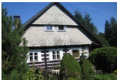
Obr. č. 170: Roubená chalupa s bohatě osázenou předzahrádkou, stěnami zpevněnými stěnovými kleštinami a třemi okny ve štítové straně. (foto: autor, 2011)
