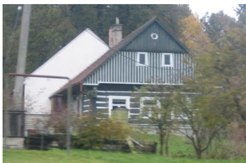
Obr. č. 254: Chalupa s prostě bedněnou lomenicí. Typ oken, který je použit na této chalupě, tzn. dělení do třech polí, patří mezi tradiční typy oken na venkově. (foto: autor, 2011)
