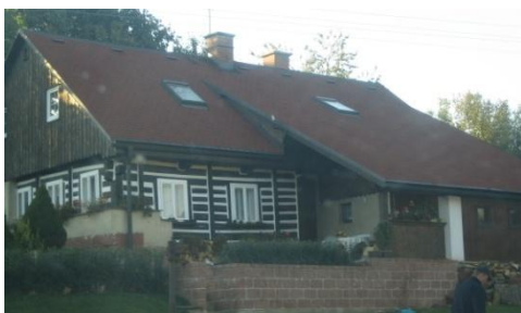
Obr. č. 281: U tohoto objektu si lze povšimnout nahrazení trámů ve spodní části štítové strany zdivem, což lze považovat za narušení výrazu stavby. (foto: autor, 2011)
