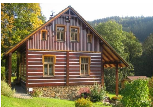
Obr. č. 249: Chalupa s podezdívkou z kamene, která slouží k vyrovnání terénu pod domem. (foto: autor, 2011)
