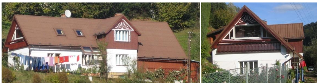
Obr. č. 260 a 261: Zděný objekt s napojenou stodolou a detail řešení štítové strany, kde se nachází okno a na stěně je napojena imitace zábradlí, což celkově působí jako krytý balkon. (foto: autor, 2011)
