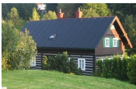
Obr. č. 233: Chalupa, na které je použita plechová střešní krytina, jež se stala výbornou náhradou za krytinu lepenkovou, protože na první pohled nijak nemění charakter stavby. (foto: autor: 2011)
