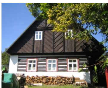
Obr. č. 184: Roubená chalupa č.p.79 u níž se nachází vzrostlý tzv. domovní strom – v tomto případě je jím lípa srdčitá ( Tilia cordata ). Celý objekt působí velice harmonickým dojmem. (foto: autor, 2011)
