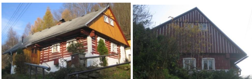
Obr. č. 137 a 138: Roubená chalupa se stěnovými kleštinami. Na pravé fotografii je zdokumentována zadní štítová strana domu, která je tvořena prkny imitujícími kvádrové zdivo. (foto: autor, 2011)
