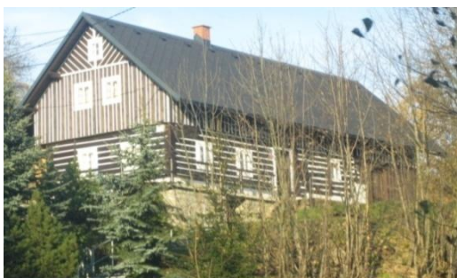
Obr. č. 144: Roubená chalupa, kde je také patrné vyrovnání terénu pro dům podezdívkou. Na stavení je nová střešní krytina. (foto: autor, 2011)
