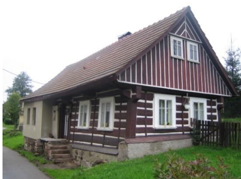
Obr. č. 218: Roubená část chalupy se stěnovými kleštinami, typickými okny dělenými do čtyř polí a patrnou podezdívkou domu, z důvodu vyrovnání terénu pod ním. (foto: autor, 2011)
