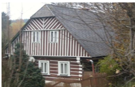
Obr. č. 206: Roubená chalupa s polovalbovou střechou na níž je eternitová střešní krytina. Spojení trámů na rozích chalupy je tzv. na zámek. (foto: autor, 2011)
