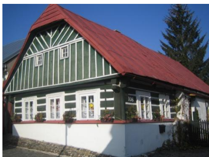
Obr. č. 115: Chalupa č. p. 108 s plechovou střešní krytinou. (foto: autor, 2011)
