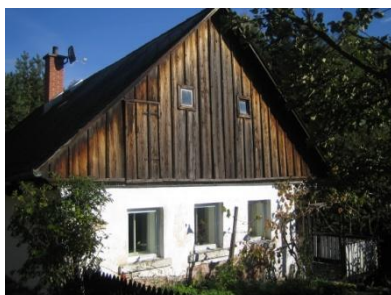
Obr. č. 257: Zděný objekt s prostě bedněnou lomenicí, na které si lze povšimnout malých okýnek sloužících k osvětlení podkroví. (foto: autor, 2011)
