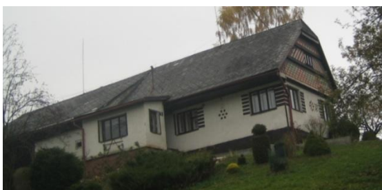
Obr. č. 249: Zděná stavba, jejíž majitelé ozdobili štít domu eternitem, který poskládaly do různě barevných obrazců. (foto: autor, 2011)
