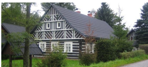
Obr. č. 213: o Peřimovu Pešta (2011) uvádí, že se jedná o vesnici s velkým zastoupením lidových staveb. Tato chalupa je důkazem bohatého zdobení a dělení lomenic na roubených stavbách. (foto: autor, 2011)
