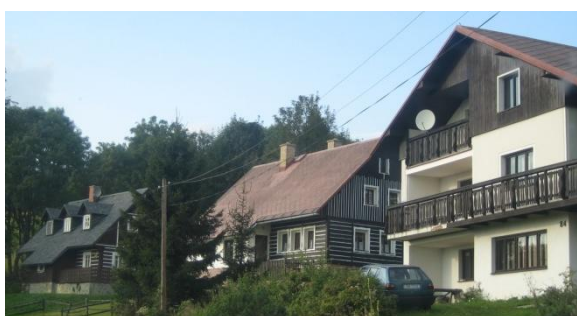
Obr. č. 104: Přizpůsobení architektury 20. století architektuře lidové. Vliv regulací území je zde patrný. Všechny objekty mají sedlový typ střechy a obdélníkový půdorys. (foto: autor, 2011)
