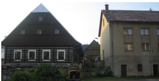
Obr. č. 151: Roubená zástavba v Poniklé, která je doplněna o dům z 20. století. (foto: autor, 2011)
