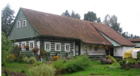
Obr. č. 217: Chalupa s pálenou střešní krytinou a jednoduše bedněnou lomenicí. (foto: autor, 2011)
