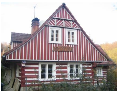
Obr. č. 142: Roubená chalupa s pálenou střešní krytinou. Vazba trámů na rozích je provedena tzv. na zámek. (foto: autor, 2011)
