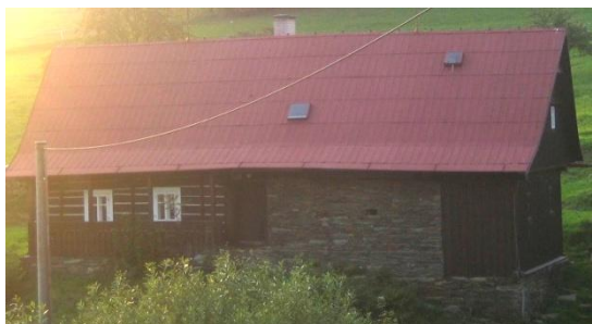
Obr. č. 154: Chalupa, jejíž přední část je roubená se světnicí, na kterou navazuje stěna zhotovená z kamene. Také je na fotografii patrná podezdívka, která je taktéž z kamene. (foto: autor, 2011)
