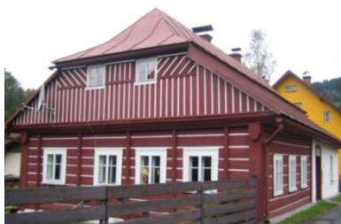
Obr. č. 167: Dům s mansardovou střechou z Jablonce nad Jizerou. (foto: autor, 2011)
