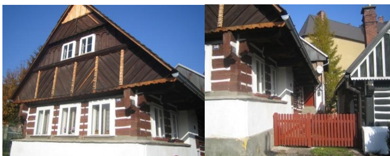
Obr. č. 116 a 117: Chalupa č. p. 106 se šindelovou střechou a nově opravenou částí lomenice. Na pravé fotografii je ukázka úzkého prostoru mezi jednotlivými chalupami. Zahrada se nachází za chalupami. (foto: autor, 2011)
