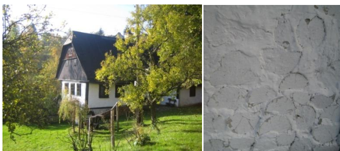
Obr. č. 5 a 6: Fotografie výjimečné dochované krčkové chalupy v Horních Štěpanicích a detail krčkové stěny. Vedle domu se nachází vzrostlý ořešák královský ( Juglans regia ). (foto: autor, 2011)
