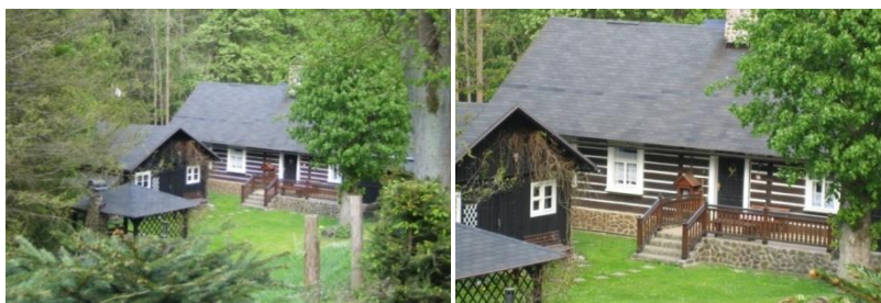
Obr. č. 79 a 80: Roubená chalupa, u které je násep doprovázena zápradlím. Za zmínku stojí také střešní krytina z asfaltového šindele. (foto: autor, 2011)
