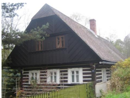
Obr. č. 271: Chalupa s bohatěji vyhotovenou lomenicí, typickými čtvercovými okny a polovalbovou střechou s eternitovou střešní krytinou. (foto: autor, 2011)
