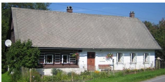
Obr. č. 179: Chalupa s roubenou světnicí a zděnou částí. Na objektu se nachází lomenice dělená do třech vodorovných pásů. Na komínech jsou vidět komínové hlavy. (foto: autor, 2011)
