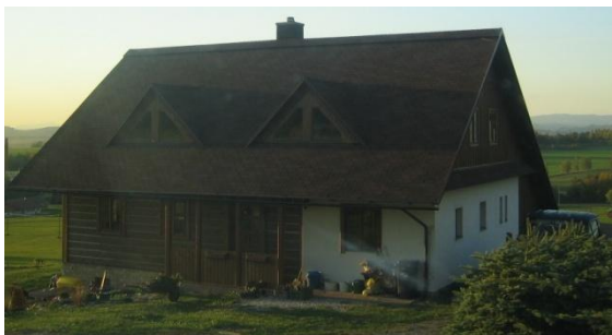
Obr. č. 283: Ukázka nové výstavby, která navazuje na dřívější objekty roubenou částí. Neobvyklé je ztvárnění vikýřů. (foto: autor, 2011)
