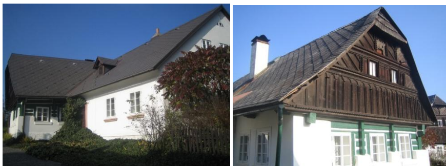
Obr. č. 121 a 122: Tato chalupa má půdorys písmene L. Světnice, která „vyčnívá“ do ulice je roubená s velice zdobnou lomenicí. Druhá část stavení je zděná. (foto: autor, 2011)
