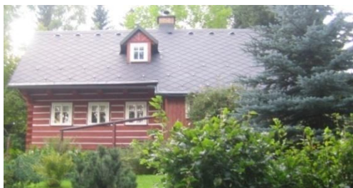
Obr. č. 106: Roubená chalupa s náspí a novou střešní krytinou. (foto: autor, 2011)
