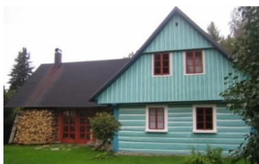
Obr. č. 166: Ukázka přístavby přistavěné k roubené chalupě. Směrem z ulice přístavba nijak zvlášť nenarušuje vzhled chalupy, protože se nachází za ní. (foto: autor, 2011)
