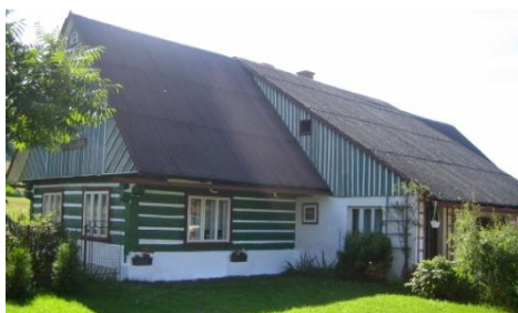
Obr. č. 185: Roubená chalupa s nevhodnými trojdílnými okny, které nepatří do prvků lidové architektury. (foto: autor, 2011)
