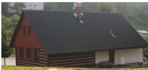
Obr. č. 49: Důkazem nové výstavby v duchu klasických roubenek je tento nový dům, na kterém je použita plechová střešní krytina celkem dobře napodobující krytinu lepenkovou. (foto: autor, 2011)
