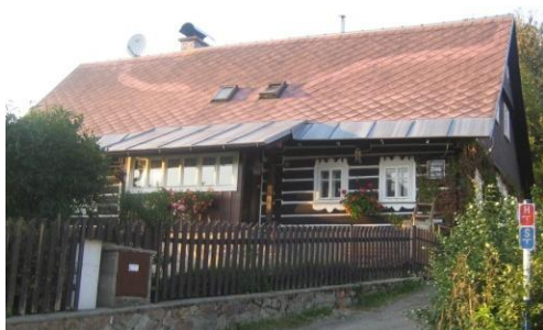
Obr. č. 237: Chalupa s okny doplněnými o okenní obložky. (foto: autor, 2011)
