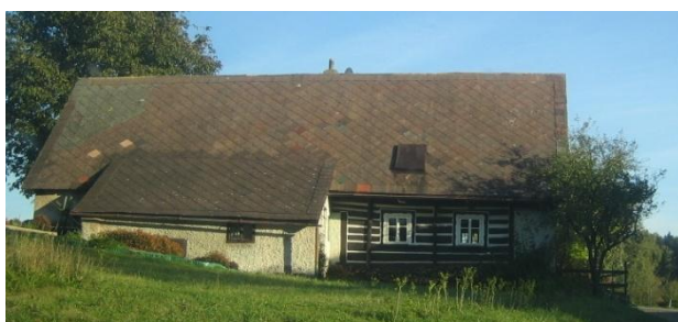
Obr. č. 275: Ukázka napojení zděné části domu na část roubenou, na které je patrné použití stěnových kleštín. (foto: autor, 2011)
