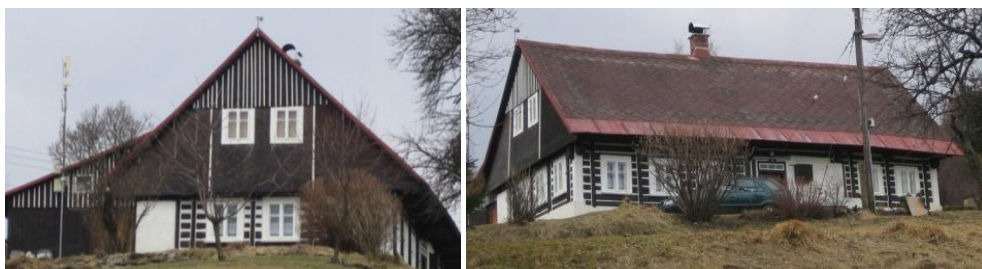
Obr. č. 9 a 10: Tato chalupa se nachází na kopci na konci vesnice. Lomenice je prostá, dělená do dvou pásů. Na stěnách jsou vidět stěnové kleštiny. (foto: autor, 2011)
