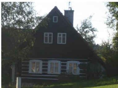
Obr. č. 279: Jednoduchá roubená chalupa působící harmonickým dojmem. (foto: autor, 2011)
