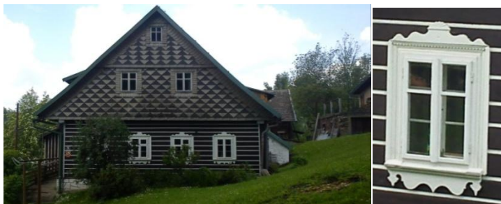
Obr. č. 93 a 94: Ukázkový příklad obloženého štítu eternitem s různým barevným odstínem a detail okenní obložky. (foto: autor, 2011)
