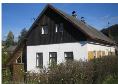
Obr. č. 256: Zděný objekt s jednoduše bedněnou lomenicí a okny, které jsou jedním z typických typů používaných na venkovských stavbách. (foto: autor, 2011)
