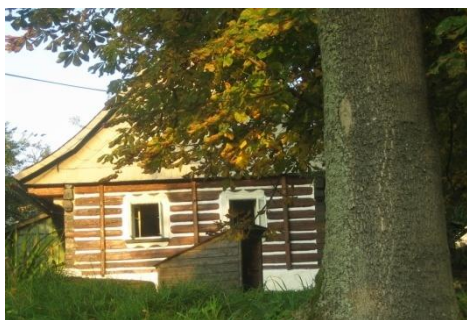
Obr. č. 148: Na této chalupě jsou stěny zpevněny pomocí stěnových kleštin. V blízkosti chalupy se nachází vzrostlý jírovec maďal ( Aesculus hippocastanum ). (foto: autor, 2011)
