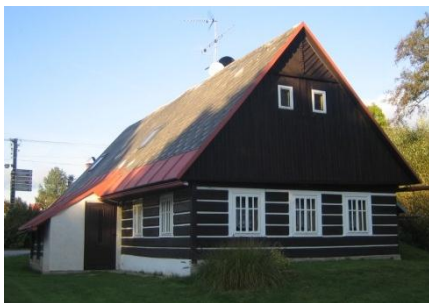
Obr. č. 280: Další zástupce z části roubeného objektu. (foto: autor, 2011)
