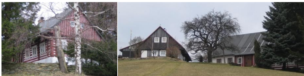
Obr. č. 11 a 12: V sousedství předchozí chalupy se nachází chalupa, jejíž roubení je ošetřeno červenou barvou. Tato chalupa má zděný zadní díl. Štítová strana chalupy je orientována na východní světovou stranu. Dominantní jsou dřeviny okolo domu: švestka domácí ( Prunus domestica ), bříza bělokorá ( Betula pendula ) a smrk pichlavý ( Picea pungens ) a smrk ( Picea abies ). (foto: autor, 2011)
