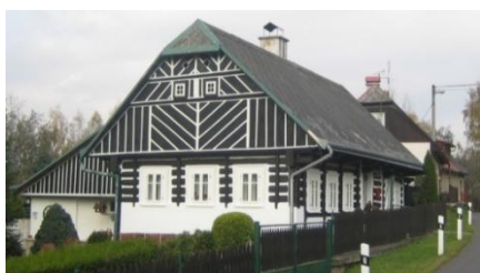
Obr. č. 198: Chalupa č. p. 165 s klasovitě bedněnou lomenicí a stěny zpevňujícími stěnovými kleštinami. (foto: autor, 2011)
