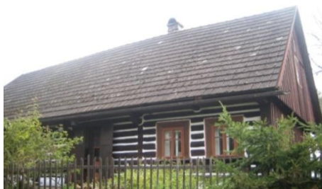
Obr. č. 196: Chalupa č. p. 153 s pálenou střešní krytinou, jednoduše bedněnou lomenicí a čtyřtabulkovými okny. (foto: autor, 2011)
