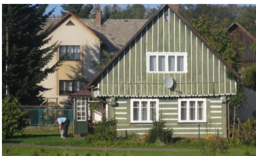
Obr. č. 285: Jeden z mála roubených objektů s prostě bedněnou lomenicí. (foto: autor, 2011)
