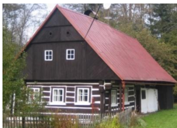
Obr. č. 194: Chalupa s typickými malými čtvercovými okny dělených křížem do čtyř polí. (foto: autor, 2011)
