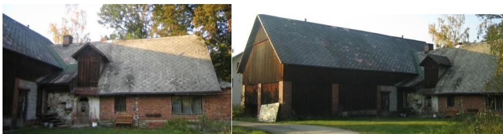
Obr. č. 54 a 55: Na těchto fotografiích je zdokumentována usedlost č. p. 36 s rozměrnou stodolou, která je napojena přímo na stavení. Za zděnou částí usedlosti se nachází mohutná lípa srdčitá ( Tilia cordata ). (foto: autor, 2011)
