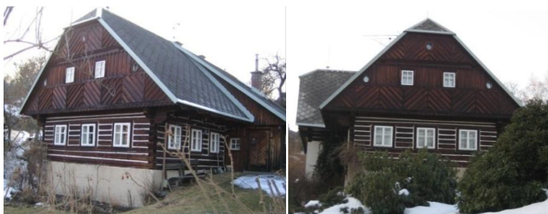
Obr. č. 3 a 4: Bohatě zdobená lomenice, která je po pečlivé rekonstrukci. (foto: autor, 2011)
