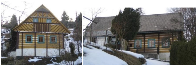
Obr. č. 7 a 8: Chalupa vyzdobená výraznými barvami a bohatě členěnou lomenicí. Na stěnách jsou typické stěnové kleštiny. Na fotografii na pravé straně je vidět zadní zděný díl chalupy a roubená pření část, kde se nachází světnice. (foto: autor, 2011)
