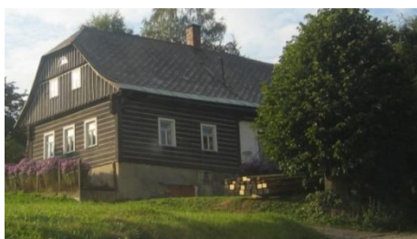
Obr. č. 110: Roubená chalupa s polovalbovou střechou a jednoduše bedněnou lomenicí. (foto: autor, 2011)
