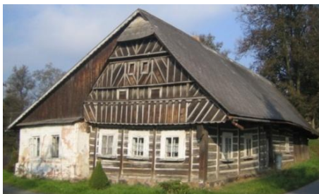
Obr. č. 190: Roubená chalupa znehodnocena zděnou přístavbou má bohadě dělenou lomenicí a stěny zpevňujícími stěnovými kleštinami. (foto: autor, 2011)
