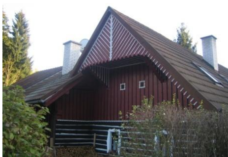
Obr. č. 277: Netypické spojení dvou částí domu a řešení lomenice. (foto: autor, 2011)
