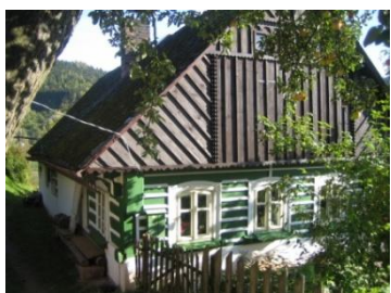
Obr. č. 259: Chalupa, jejíž zadní část je zděná, nepůvodní. Majitelé se rozhodli provést rekonstrukci a vyměnit roubenou konstrukci za zděnou. I přes to si chalupa zachovala svůj půvab, nejspíš díky klasovitě bedněné lomenici. (foto: autor, 2011)
