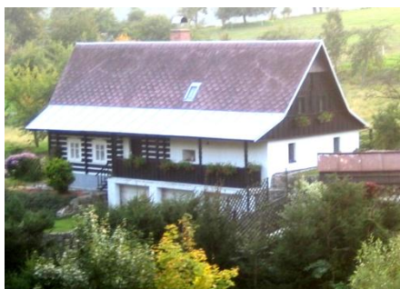
Obr. č. 153: Spojení roubené části a zděné přístavby. (foto: autor, 2011)
