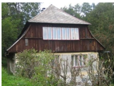
Obr. č. 107: Zděná stavba s mansardovou střechou s nepůvodními okny. (foto: autor, 2011)
