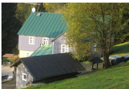
Obr. č. 59: Zděný dům se svislým pobitím latěmi a plechovou střešní krytinou na Benecku. (foto: autor, 2011)
