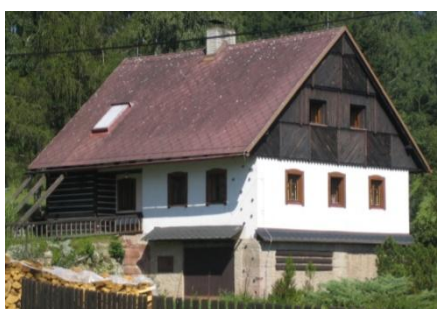
Obr. č. 183: Zrekonstruovaný objekt s původní roubenou zadní částí domu. Na přední štítové straně lze vidět lomenici s klasovitě provedeným bedněním. (foto: autor, 2011)
