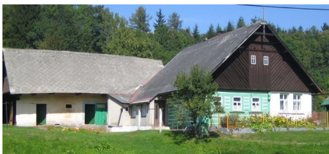
Obr. č. 182: Příklad z Levínské Olešnice, kde lze vidět napojení hospodářské části objektu na část obytnou. (foto: autor, 2011)
