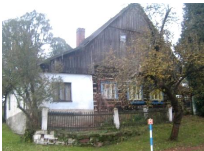
Obr. č. 252: Chalupa, která je obohacena o zděnou přístavbu, která změnila půdorys objektu i tvar střešní konstrukce a ukázka nepůvodních a ne příliš vhodný trojdílných oken. (foto: autor, 2011)
