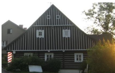
Obr. č. 239: Roubená chalupa s jednoduše bedněnou lomenicí a stěny zpevňujícími stěnovými kleštinami. (foto: autor, 2011)
