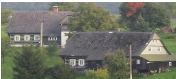
Obr. č. 152: Chalupy, které si jsou velice podobné. Avšak na chalupě v popředí zpevňují stěny stěnové kleštiny a chalupa v pozadí má zděnou polovinu domu, která je kryta vzrostlým stromem a chalupou. (foto: autor, 2011)
