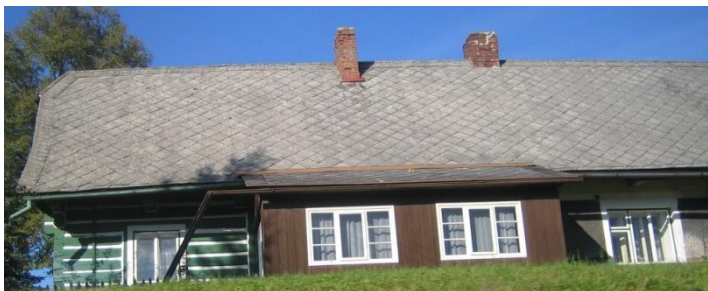
Obr. č. 263: Objekt, na kterém jsou použity tři typy dělení oken, což působí celkem chaotickým dojmem. (foto: autor, 2011)
