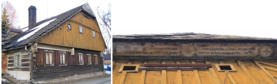
Obr. č. 1 a 2: Jeden z domů nacházející se v centru vesnice s dochovaným záklopovým prknem. (foto: autor, 2011)
