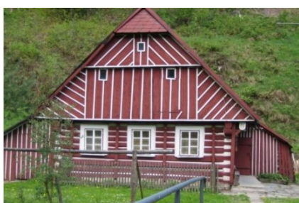
Obr. č. 81: Roubená chalupa se stěnovými kleštinami a malými větracími okénky v lomenici. (foto: autor, 2011)
