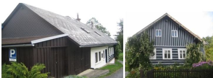
Obr. č. 108 a 109: Chalupa s roubenou světnicí, zděným prostředním dílem a přistavěnou kůlou. (foto: autor, 2011)
