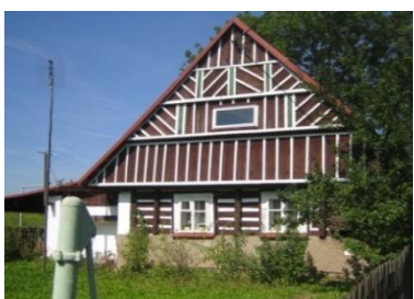
Obr. č. 169: Chalupa s bohatě dělenou lomenicí do čtyř vodorovných pásů. Dále jsou patrná typická čtvercová okna a stěny zpevňující stěnové kleštiny. (foto:autor, 2011)
