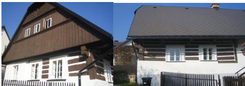
Obr. č. 119 a 120: Chalupa č. p. 111 s roubenou světnicí a zděným zadním dílem. Na fotografii můžeme vidět novou střešní krytinu. (foto: autor, 2011)
