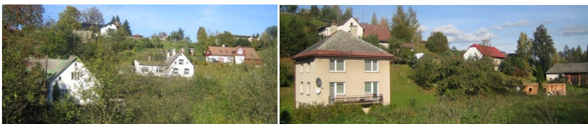
Obr. č. 268: Pohled na dvě části zástavby v Čisté u Horek, která je pohlcena v zeleni. (foto: autor, 2011)
