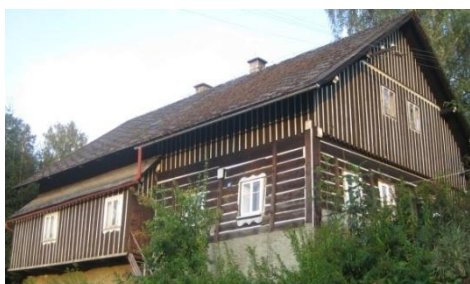
Obr. č. 155: Roubená chalupa č. p. 92, která má v přední štítové straně tři okna, což je prvek typický původně pro chalupy tkalců, kteří měli vysoké nároky na osvětlení světnice. (foto: autor, 2011)
