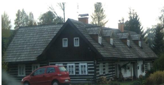
Obr. č. 202: Chalupa č. p. 76 v Roztokách u Jilemnice se šindelovou střešní krytinou. (foto: autor, 2011)
