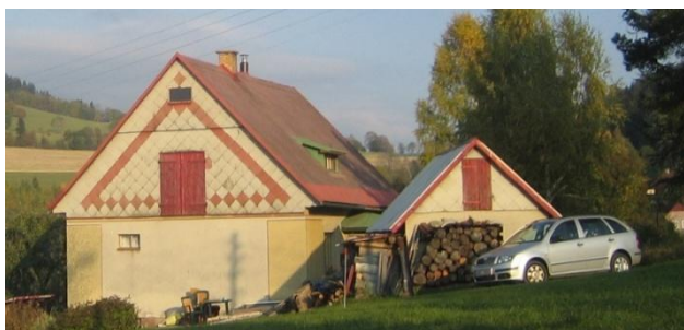
Obr. č. 56: Ukázkové obložení štítu barevným eternitem složeným do obrazce. (foto: autor, 2011)
