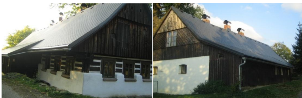
Obr. č. 52 a 53: Chalupa s prostě bedněnou lomenicí a typickým zalomením střechy pro hambálkové krovy. Je zde vidět také správné umístění komínů, tzn. na druhé straně hřebenu střechy než je vchod do chalupy. (foto: autor, 2011)
