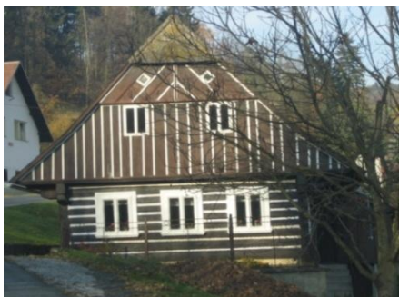
Obr. č. 143: Roubená chalupa s jednoduše bedněnou lomenicí a polovalbovou střechou. (foto: autor, 2011)
