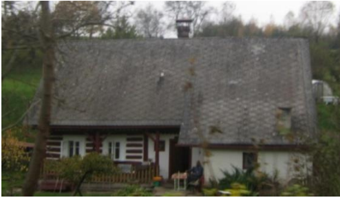
Obr. č. 250: Typická chalupa s roubenou světnicí a zděnou částí objektu. (foto: autor, 2011)
