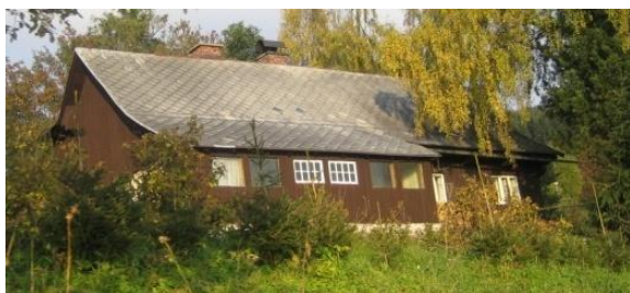
Obr. č. 60: Chalupa, u které je patrné zalomení střechy díky použití hambalkového typu krovu. (foto: autor, 2011)
