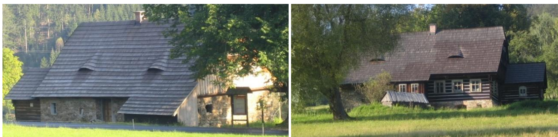
Obr. č. 242: Tato chalupa se šindelovou střechou, která dříve sloužila jako obecní škola. (foto: autor, 2011)
