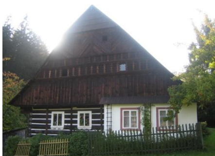
Obr. č. 245: Chalupa č.p. 94 s ojedinělým zdobením lomenice. Je zde vyhotovena dvojitá tzv. kočičí procházka. (foto: autor, 2011)
