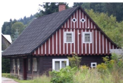
Obr. č. 162: Další ze rástupců roubených chalup z Jablonce nad Jizerou s tmavě nabarvenými spárami. (foto: autor, 2011)
