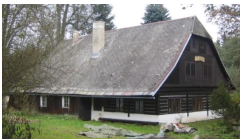
Obr. č. 225: Bývalý mlýn, který se nachází v Martinicích v Krkonoších v těsní blízkosti Martinického rybníka. Na chalupě si lze všimnout polovalbové střechy, zdobené bedněné lomenice či stěny zpěvňující stěnové kleštiny. (foto: autor, 2011)
