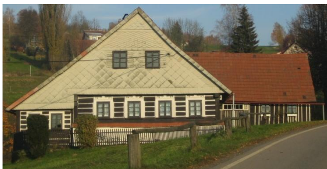
Obr. č. 146: Další příklad chalupy s obloženým štítem eternitovou střešní krytinou. Na chalupě je patrná narušená symetričnost štítové strany, k čemuž došlo díky vybudování přístavby. (foto: autor, 2011)
