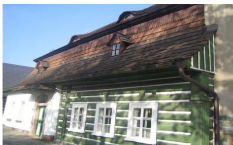
Obr. č. 112: První stavba ve zvědavé uličce s mansardovou střechou a šindelovou střešní krytinou. (foto: autor, 2011)
