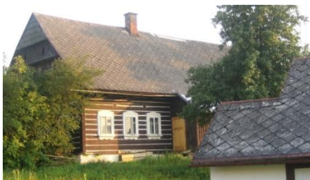
Obr. č. 149: Chalupa, která se nachází v centrální části vesnice s polovalbovou střechou, prostě bedněnou lomenicí, ve které jsou dva malé větrací otvory. Okenní parapet naznačují vyřezaná prkénka pod okny. (foto: autor, 2011)
