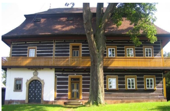
Obr. č. 187: Tzv. Tuláčkův statek se řadí mezi jeden z mála dochovaných patrových domů. Je to stavba s pavlačí a mansardovou střechou, což mu přidává na výjimečnosti. (foto: autor, 2011)
