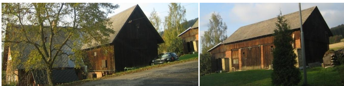
Obr. č. 50 a 51: Na těchto fotografiích je zdokumentována zděná usedlost, ke které patří samostatně stojící stodola. (foto: autor, 2011)
