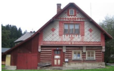
Obr. č. 168: Stavba se stítem obloženým eternitem a přístavkem, který narušuje symetričnost střechy stavby. (foto: autor, 2011)
