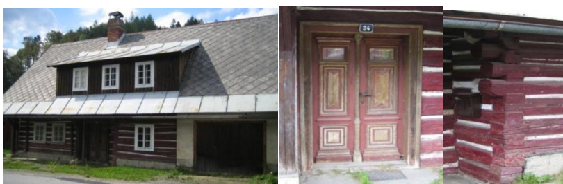
Obr. č. 72, 73 a 74: Na této chalupě stojí za pozornost dveře, které jsou vyzdobeny řezbou. Na chalupě lze poukázat i na spojení trámů tzv. na rybinu detail viz. obr. č. 85. (foto: autor, 2011)
