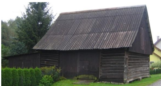
Obr. č. 210: Stodola jako důkaz toho, že dřevěné stavby neustále pracují a že původně rovné části se po čase zdeformují. (foto: autor, 2011)
