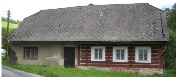
Obr. č. 75: Chalupa, jejíž stěny na roubené části jsou zpevněny stěnovými kleštinami. Okna jsou doplněna o jednoduché okenní obložky. Střecha je polovalbová, lomenice prostě bedněná s malými větracími otvory ve vrchním vodorovném dílu. (foto: autor, 2011)
