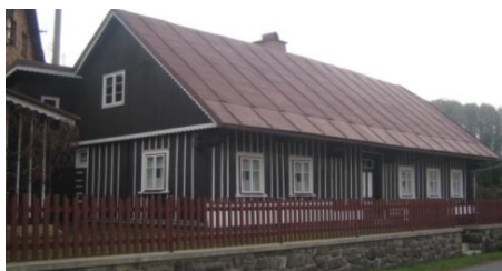
Obr. č. 197: Chalupa se svislým pobitím stěn. (foto: autor, 2011)
