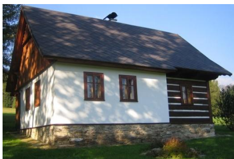
Obr. č. 243: Vydařená novostavba se znaky lidové architektury – podezdívka domu z kamene, čtvercová okna, která nejsou zapadlá. (foto:autor, 2011)
