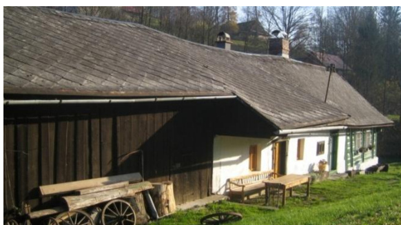
Obr. č. 139: Roubená chalupa se světnicí a napojenou zděnou částí. Stodola je s domem spojena. (foto: autor, 2011)
