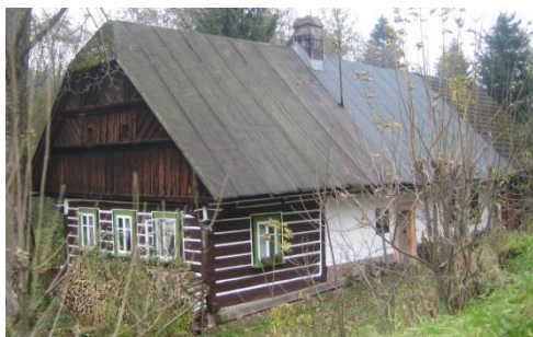
Obr. č. 272: Objekt, na kterém je patrné rozdělení domu do tří částí, v přední části roubená světnice, prostřední zděný díl se síní a dále napojená hospodářská část – stodola. (foto: autor, 2011)
