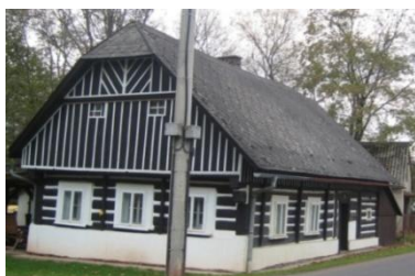
Obr. č. 200: Jednoduchá roubená chalupa č. p. 8 s malými okny a jednoduše bedněnou lomenicí. (foto: autor, 2011)
