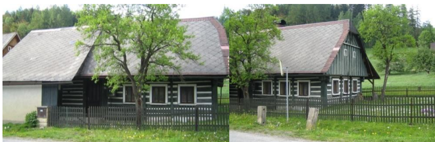
Obr. č. 70 a 71: Roubená chalupa se zděným zadním dílem, která má střídavě dělenou lomenici do dvou polí. Střešní krytina je z eternitu. Stěny roubené části chalupy jsou zpevněny pomocí stěnových kleštín. (foto: autor, 2011)
