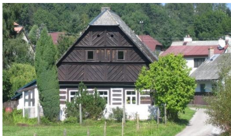
Obr. č. 177: Roubená chalupa s klasovitě bedněnou lomenicí a v ní s malými větracími otvory. (foto:autor, 2011)
