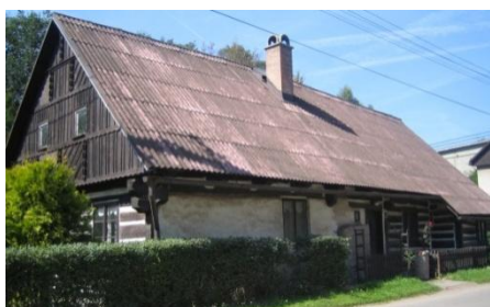
Obr. č. 169: Roubená chalupa se zděnou částí směrem k silnici, velice bohatě skládanou lomenicí a zdobnou hlavou komína. (foto:autor, 2011)
