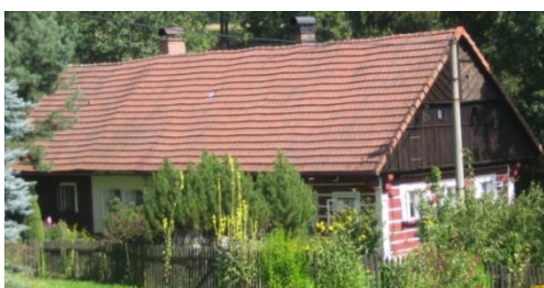
Obr. č. 168: Chalupa s roubenou světnicí, zděným prostředním dílem (se síní) a komorami. (foto: autor, 2011)
