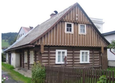
Obr. č. 163: Chalupa se zpevňujícími stěnovými kleštinami a zajímavě a decentně zdobeným zakončením lomenice. (foto: autor, 2011)
