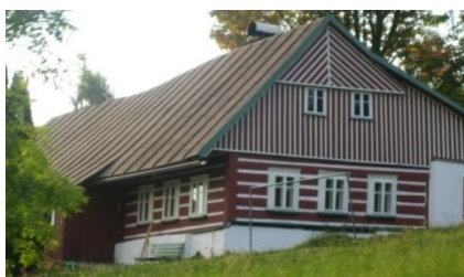
Obr. č. 100: Roubená chalupa s plechovou střešní krytinou. (foto: autor, 2011)
