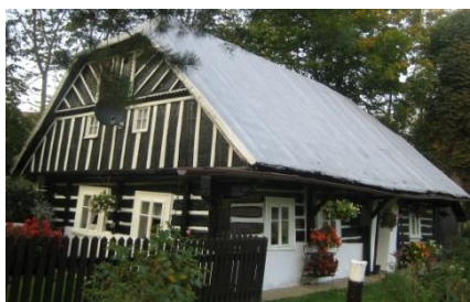
Obr. č. 156: Roubená chalupa s lepenkovou střešní krytinou. Přes léto byla chalupa v obložení begonií ( Begonia tuberhybrida ). (foto: autor, 2011)
