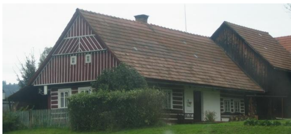
Obr. č. 214: Roubená chalupa, na které je použita pálená střešní krytina. (foto: autor, 2011)
