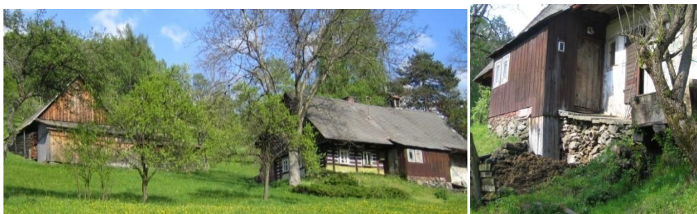
Obr. č. 85 a 86: Roubená chalupa se samostatně stojící stodolou, vzrostlým ořešákem a ovocným sadem. Zadní díl domu je zděný. (foto: autor, 2011)
