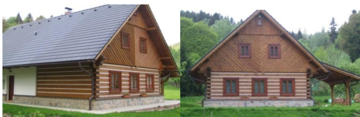
Obr. č. 76 a 77: Novostavba z Dolních Štěpanic. Přední díl chalupy je roubený, zadní zděný, tak jak tomu bývá u typických starších lidových chalup. Spojení trámů na rozích stavby je provedeno tzv. na rybinu. (foto: autor, 2011)
