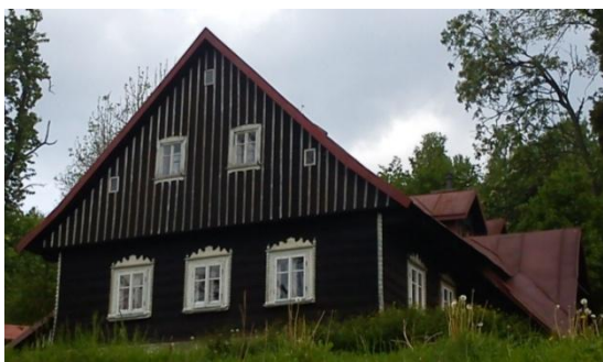
Obr. č. 95: Chalupa se zdobenými okenními obložkami a jednoduše bedněnou lomenicí. (foto: autor, 2011)
