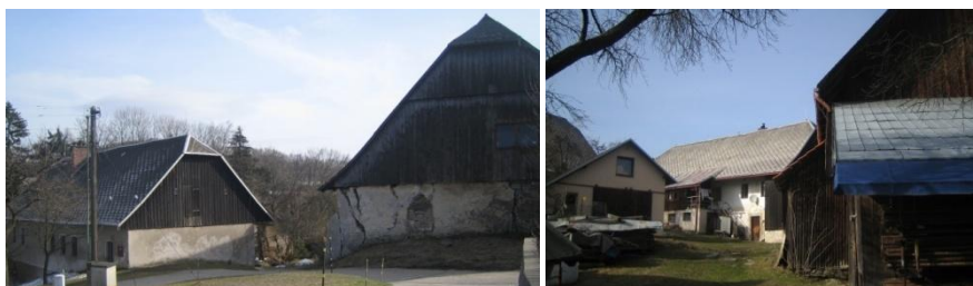
Obr. č. 13 a 14: Nejrozlehlejší usedlost v Horních Štěpanicích Ve dvoře. Pešta (2011) o ní uvádí, že dříve mohla být panským dvorem štěpanického hradu. Na fotografii je pohled na dvůr obklopený stodolou a stavbou z 90. let 20 století. (foto: autor, 2011)
