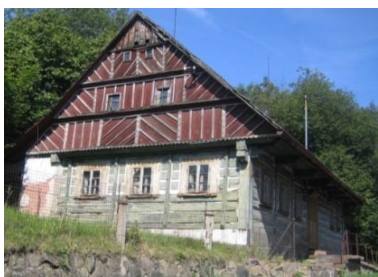
Obr. č. 167: Roubená chalupa s klasovitě bedněnou lomenicí. (foto: autor, 2011)
