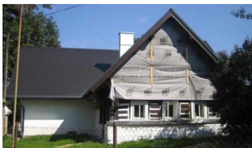
Obr. č. 180: Zaznamenání probíhající rekonstrukce chalupy v Levínské Olešnici. (foto: autor, 2011)
