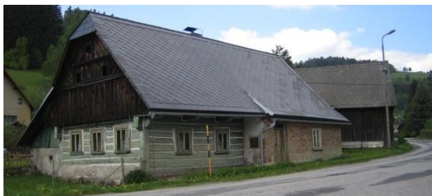
Obr. č. 67: Chalupa č. p. 17 s roubenou a zděnou částí bohužel v chátrajícím stavu. Pozornost si zaslouží především lomenice, která je rozdělena do třech vodorovných pásů. (foto: autor, 2011)
