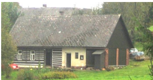
Obr. č. 253: Zde je zdokumentována chalupa, na které je vidět původní trojdílné uspořádání domu s roubenou světnicí, zděným dílem a stodolou. Typ oken použitý na této stavbě je podle Knoppa a kol. (1994) jeden z tradičních typů používaných na lidových stavbách (foto: autor, 2011)
