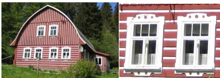
Obr. č. 83 a 84: Roubená chalupa ve Vítkovicích v Krkomoších na propojovací cestě na Benecko. Typická je především netypickým tvarem střechy. Na pravé fotografii je znázorněn detail okenních obložek. (foto: autor, 2011)
