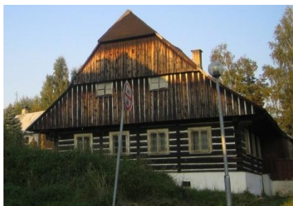
Obr. č. 236: Počet oken na této chalupě dokazují dřívější velké nároky na osvětlení světnice. (foto: autor, 2011)
