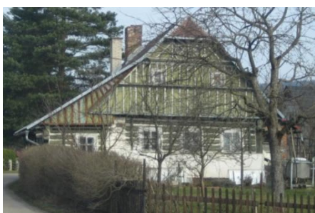
Obr. č. 224: Chalupa s roubenou světnicí a žěným zadním dílem. (foto: autor, 2011)
