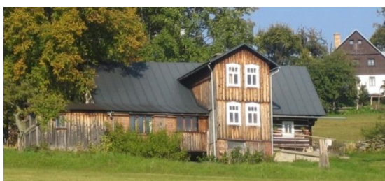
Obr. č. 241: Objekt znehodnocený trojdílnými okny s novou plechovou střešní krytinou. (foto:autor, 2011)
