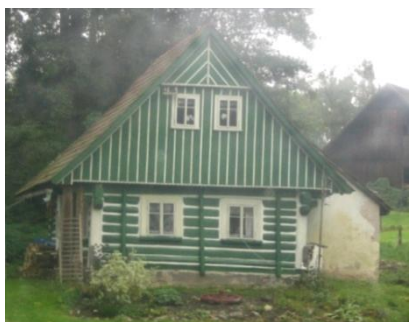
Obr. č. 215: Další roubená chalupa se stěnovými kleštinami. (foto: autor, 2011)
