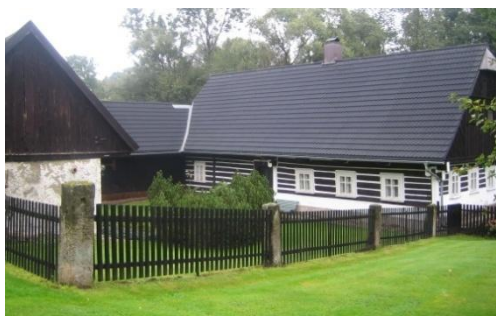
Obr. č. 211: Usedlost, jejíž dvůr je obklopen ze tří stran obytnou a hospodářskými budovami. Majitel provedl rekonstrukci střešní krytiny. (foto: autor, 2011)
