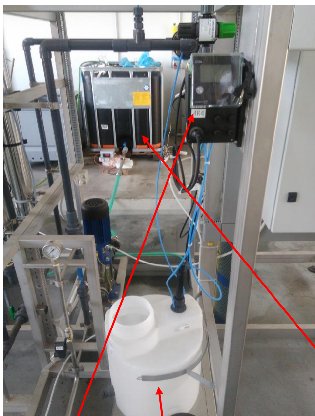
Obrázek 9.2 Dávkovací čerpadlo s kontejnerem na přídatné chemikálie; černá nádrž
