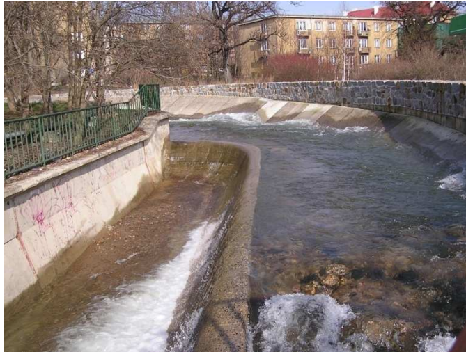
Obrázek č. 1 Rozvodnění Bílého potoka v roce 2005
