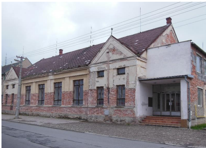
Obrázek 5.1 – Aktuální stav sokolovny – čelní pohled
