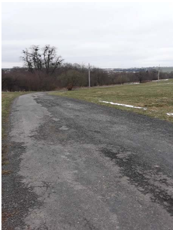
Obr. 36: Úsek komunikace u obce Luboměř pod Strážnou (Hlavačková E., listopad 2019)
