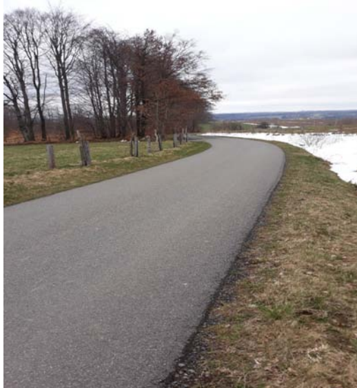
Obr. 10: Cesta za osadou Kouty směr na Boškov, s upraveným asfaltovým povrchem (Hlavačková E., listopad 2020)
