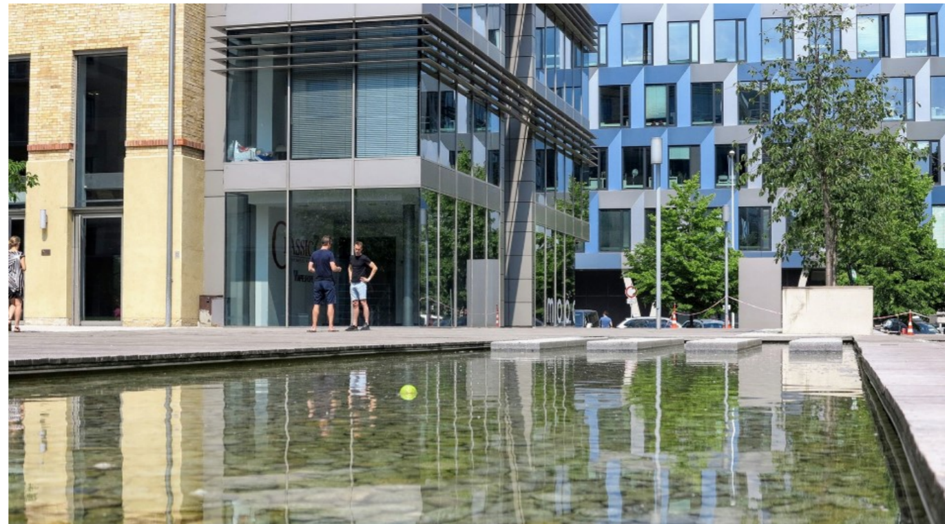
Obr. 39. Classic 7, obnova brownfieldu (zdroj: Terra Florida)
