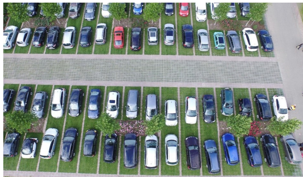
Obr. 27. Parkovací zasakovací plocha (zdroj: MZI)
