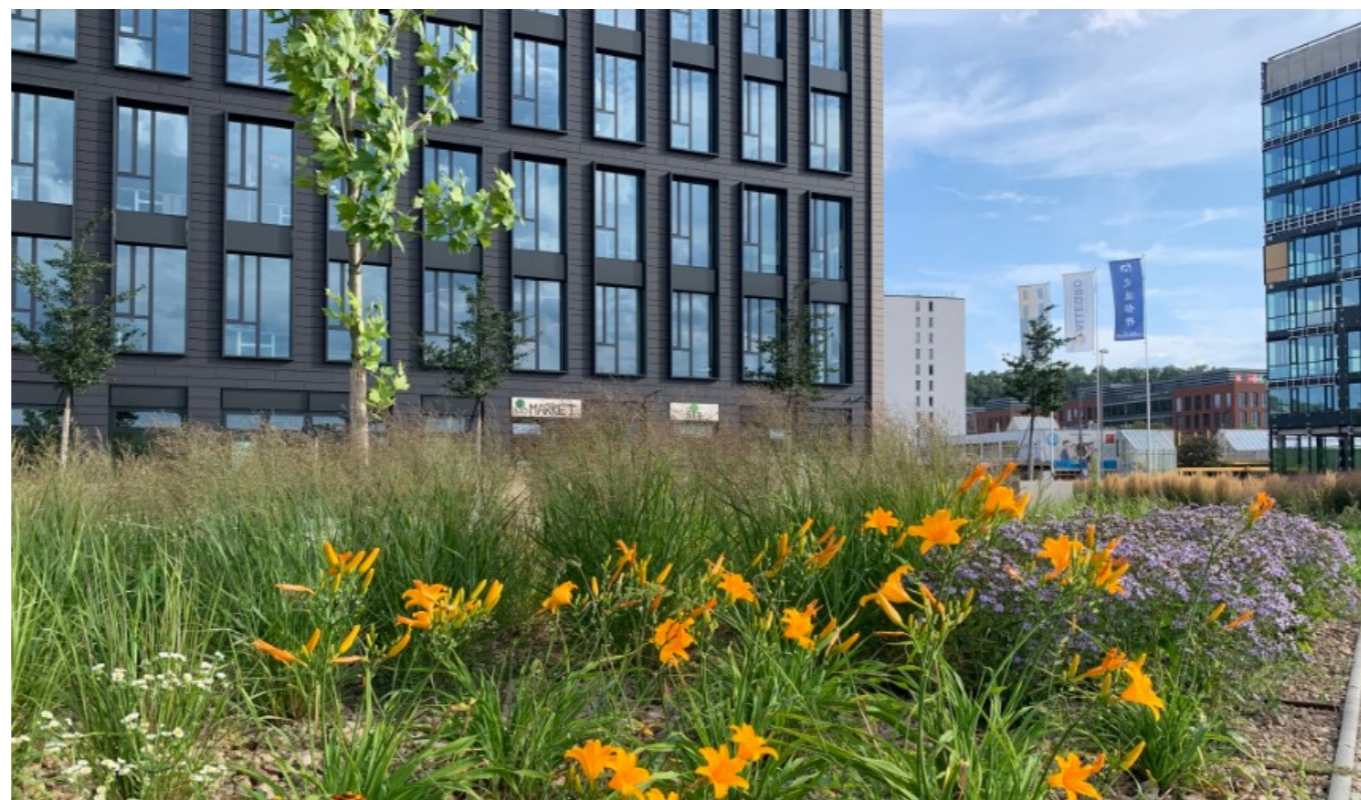
Obr. 65. Administrativní komplex Rustonka (zdroj: J. Pyšková)
