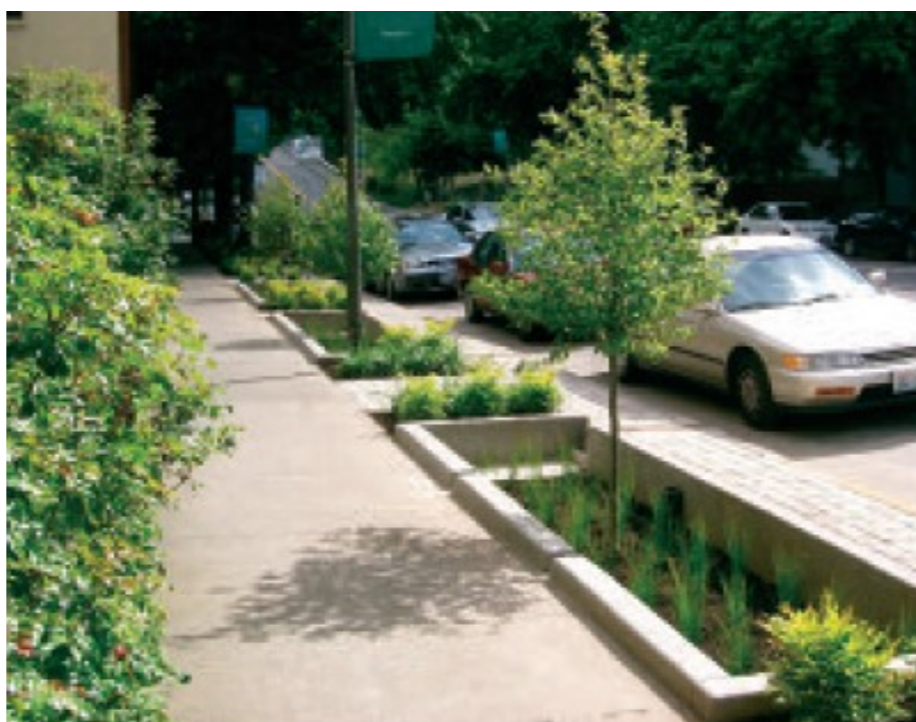
Obr. 26. Uliční stromový příkop (zdroj: Rain gardens)
