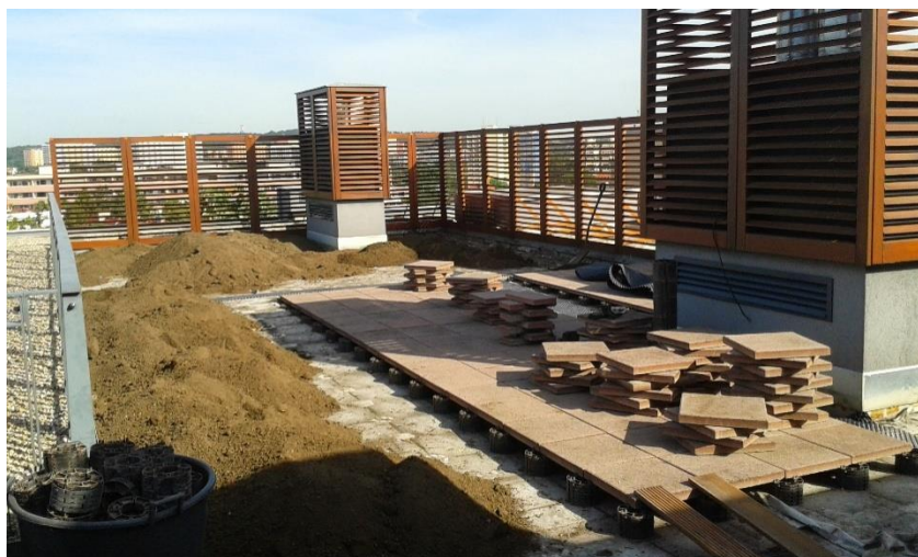
Obr. č. 28.: Průběh realizace střešní zahrady, Praha – Prosek (autor: Jaromír Nigrin)
