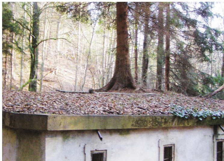
Obr. č. 8.: Smrk ztepilý na střeše staré vodárny, Vlčí rokle na Gryble, Týnec nad Sázavou (převzato z publikace: Zvláštní tvary dřevin, 2014)
