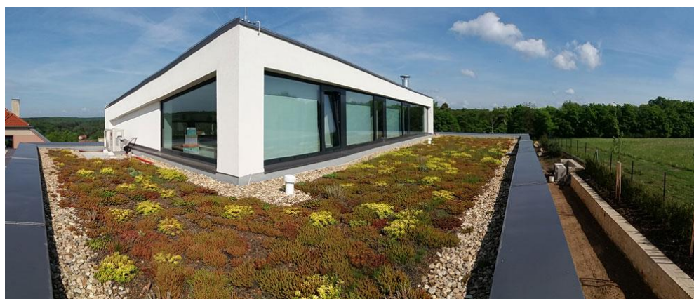
Obr. č. 6.: Extenzivní zelená střecha v Hostěnicích, 2. místo 2017, (převzato z: http://www.zelenestrechy.info/cs/ )
