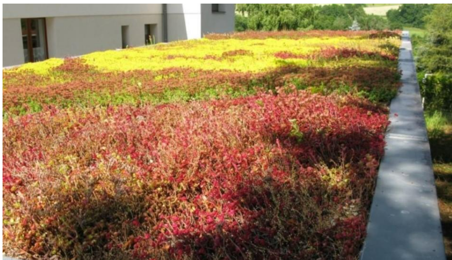
Obr. č. 9.: Extenzivní střecha ve Volyni (převzato z: www.acre.cz )
