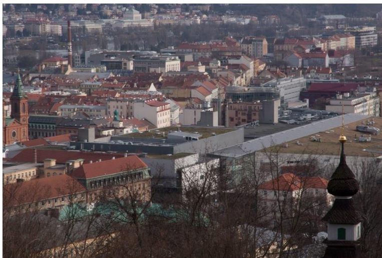
Obr. č. 4.: Pohled na extenzivní střechy OC Smíchov, (autor: Barbora Pánková)
