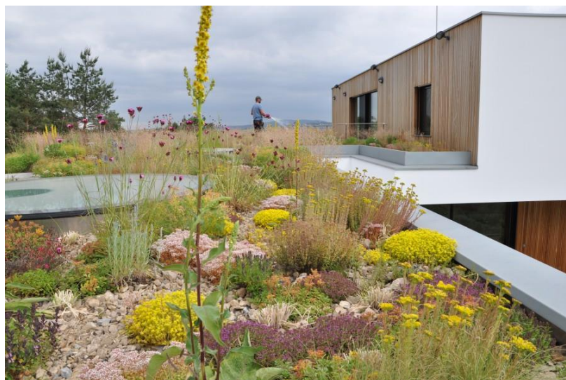
Obr. č. 5.: Zelená střecha rodinného domu „NA RŮMECH VE ZLÍNĚ“, 1. místo 2017, (převzato z: http://www.zelenestrechy.info/cs/ )
