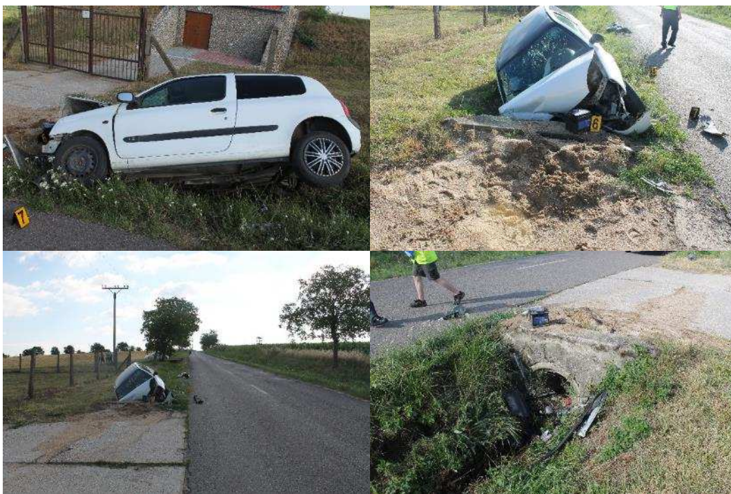
Obrázek 28 Propustek, III/42112 Vrbice - Bořetice - přímý úsek 106
