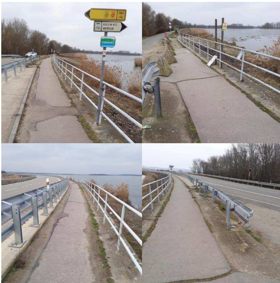
Obrázek 29 Svodidla, zábradlí II/420 Strachotín - Dolní Věstonice 108
