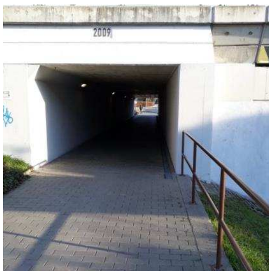
Obrázek 30 Břeclav, ul. Bratislavská železniční most 110
