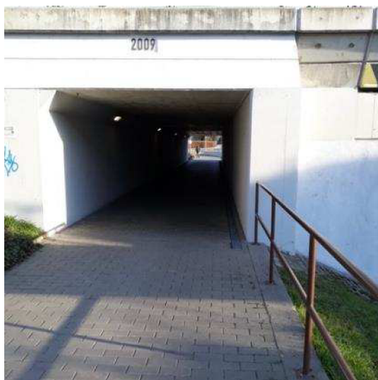
Obrázek 30 Břeclav, ul. Bratislavská železniční most 110
