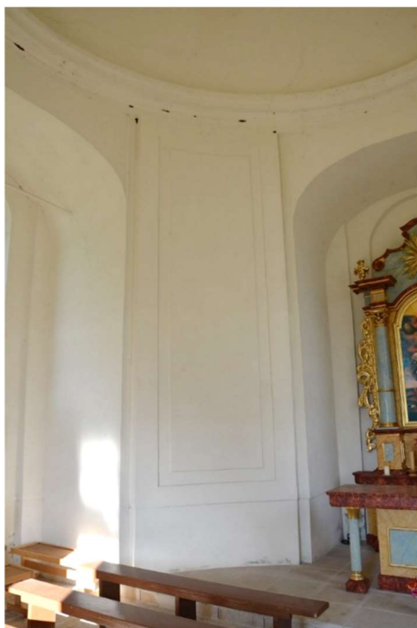
Obr. 10/ Slavkov u Brna, kaple sv. Urbana, interiér, stěna mezi nikami
