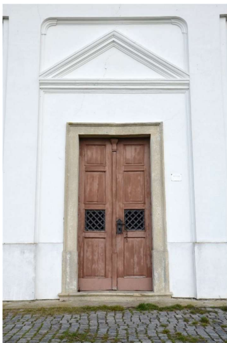
Obr. 3/ Slavkov u Brna, kaple sv. Urbana, vstup do kaple
