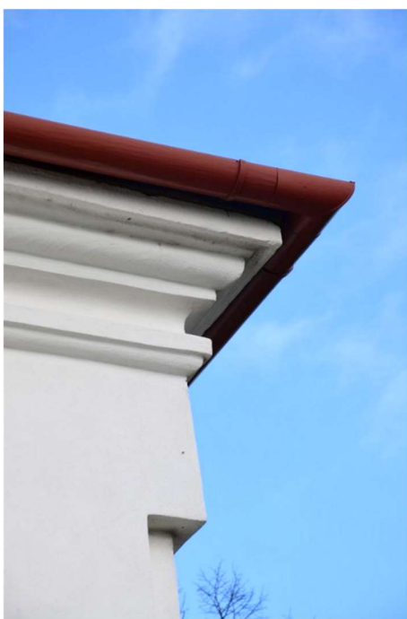
Obr. 8/ Slavkov u Brna, kaple sv. Urbana, detail korunní římsy a „efektu volného rohu“
