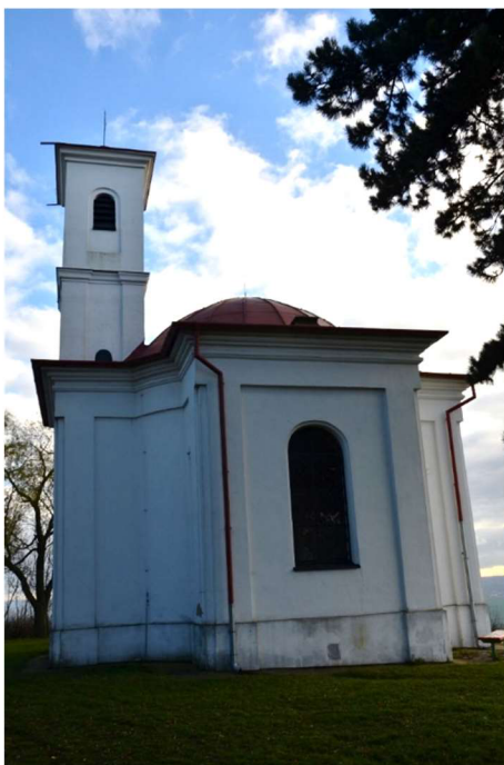
Obr. 6/ Slavkov u Brna, kaple sv. Urbana, pohled od severozápadu
