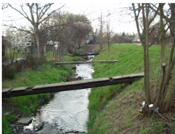
Obr. 6.10 Řada lávek v ř. km 2,930 – 3,183 [1]
