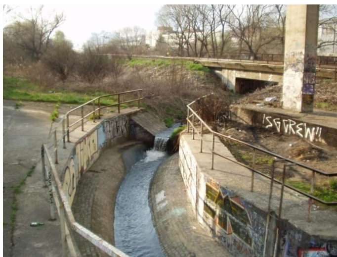
Obr. 6.9 Betonové koryto v ř. km 2,293 – 3,355 [1]
