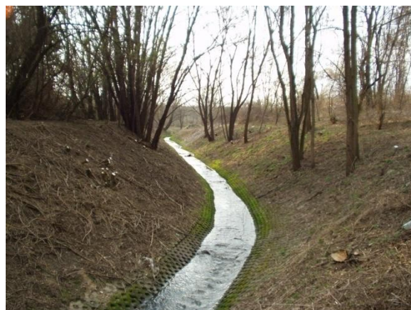
Obr. 6.7 Část koryta v ř. km 1,600 - 1,837 [1]
