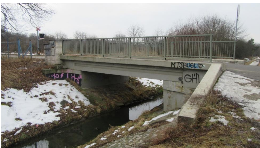
Obr. 6.22 Most na ř. km. 3,843
