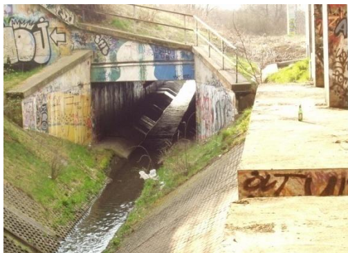
Obr. 6.16 Zaklenutí na ř. km. 2,293 – 2,337 – pohled proti vodě [1]
