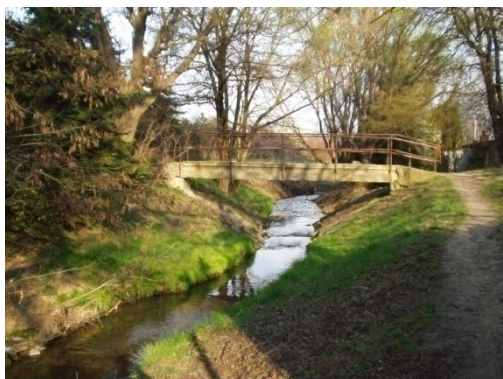
Obr. 6.19 Betonová lávka na ř. km. 3,244
