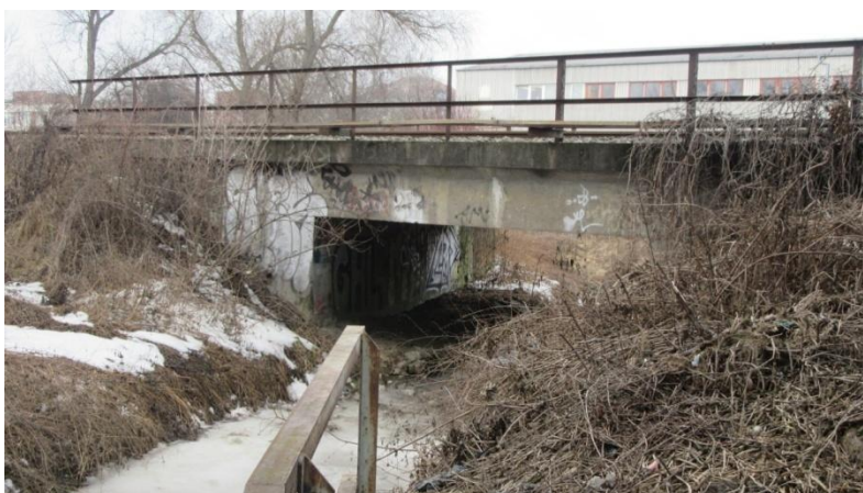
Obr. 6.17 Železniční most na ř. km. 2,366
