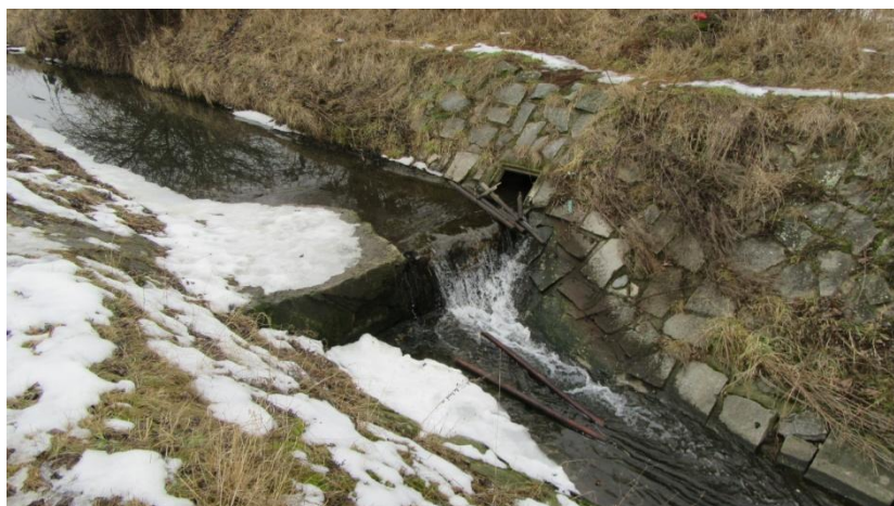
Obr. 6.20 Spádový stupeň na ř. km. 3,594
