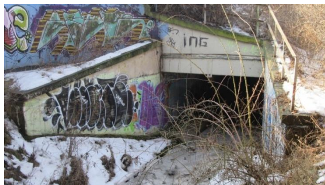
Obr. 6.8 Výtok zaklenutí v ř. km 2,337
