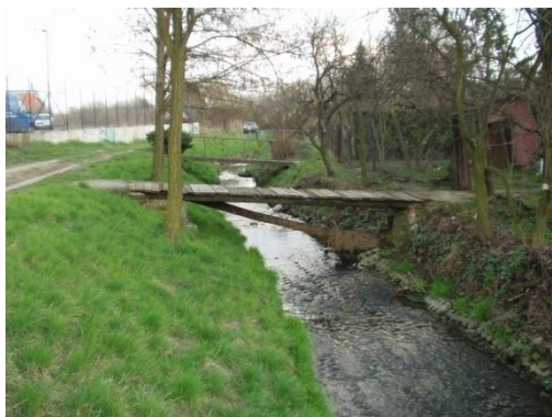
Obr. 6.18 Lávky na ř. km. 2,930 – 3,183
