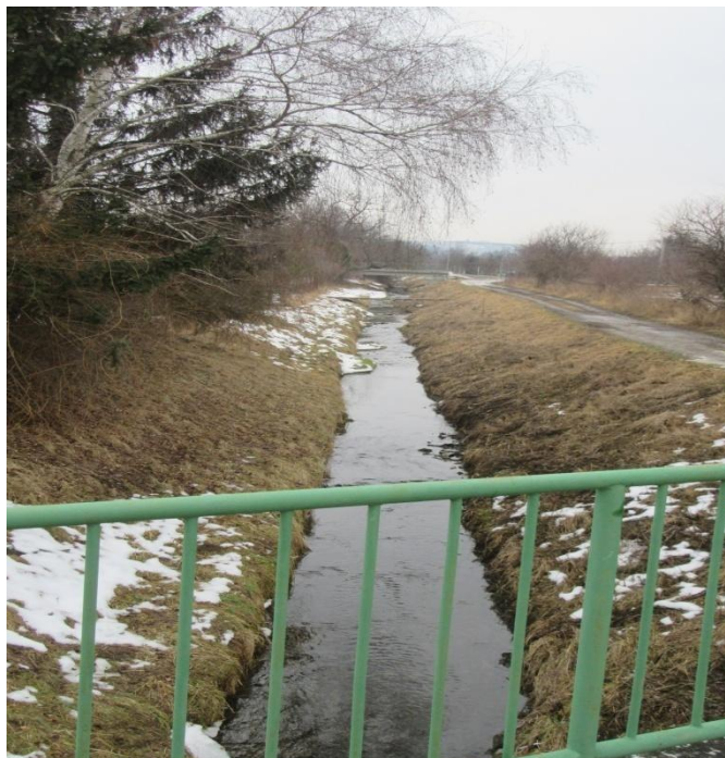
Obr. 6.11 Charakter koryta v ř. km 3,183 – 3,843
