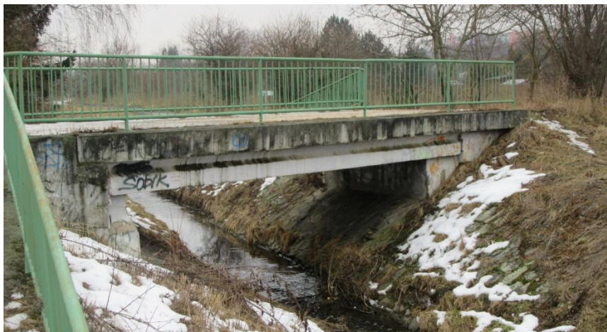
Obr. 6.21 Most na ř. km. 3,702
