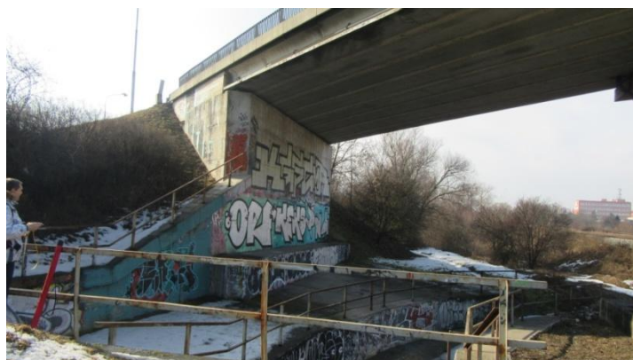
Obr. 6.15 Dálniční most na ř. km. 2,337 – pohled proti vodě
