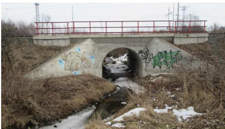
Obr. 6.12 Most na ř. km. 1,600
