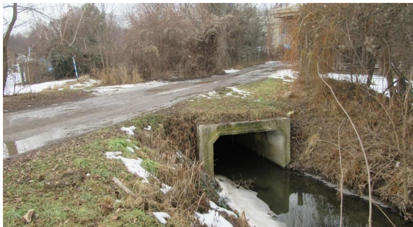
Obr. 6.13 Most na ř. km. 1,695
