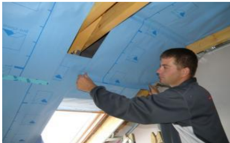
Obr. 5 Aplikace parozábrany ( www.abs-portal.cz )
