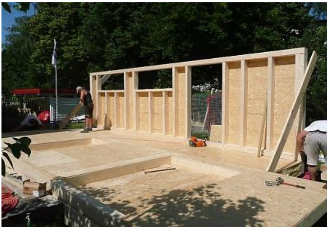
Obr. 1 Montáž rámu s jednostranným opláštěním na staveništi ( www.svet - drevostavby.cz )
