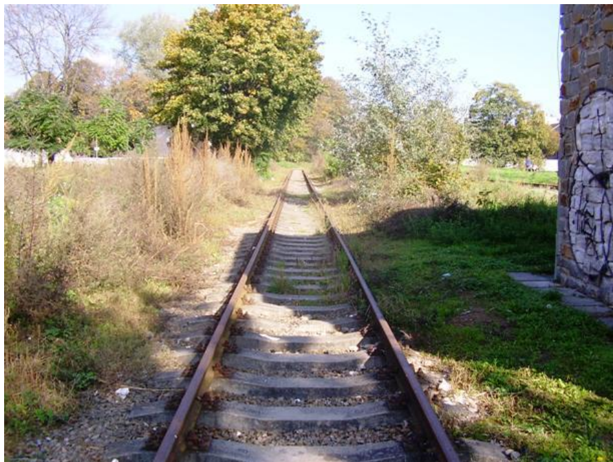
Obr. 17 Zachovalé koleje u obce Drásov (zdroj: cestovatel.cz)
