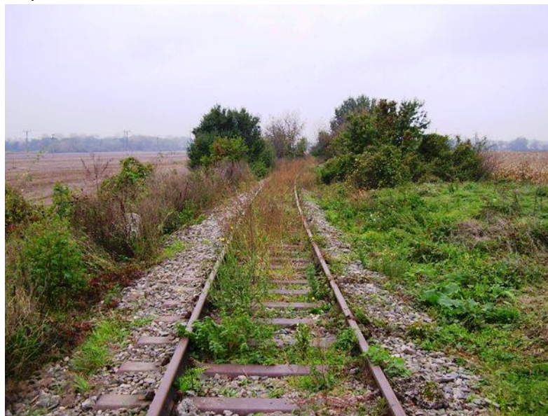
Obr.33 Zarostlý úsek trati Hrušovany – Židlochovice (zdroj: turistika.cz)
