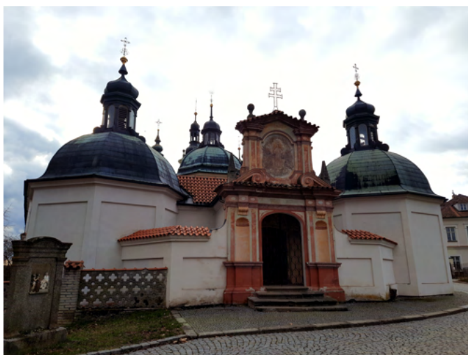
Obrázek 16: Poutní areál s kostelem Nanebevzetí Panny Marie v Klokotech
