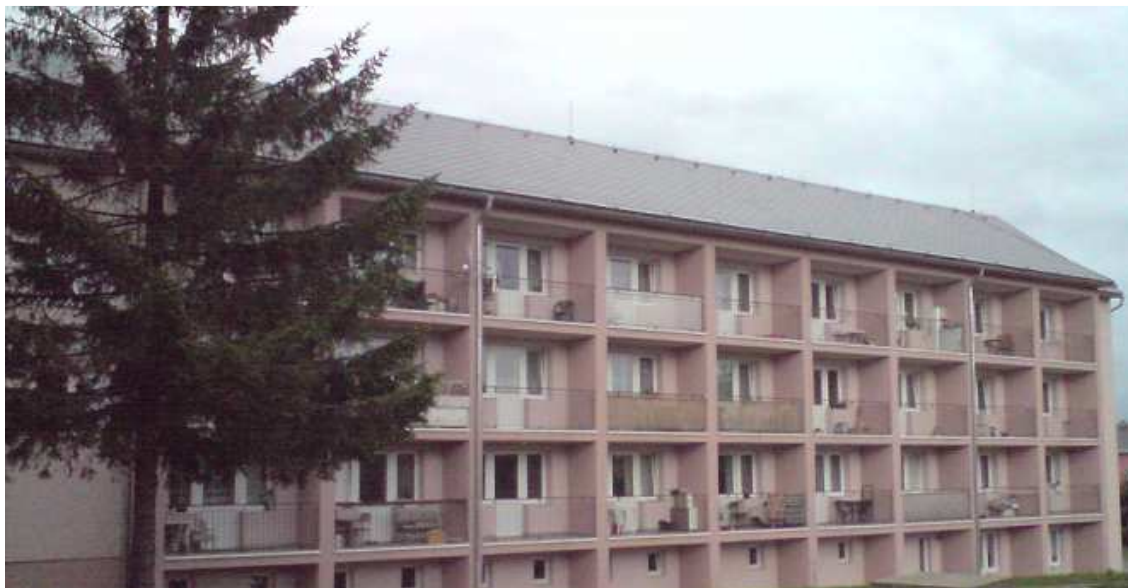
Obrázek 6 – foto domu s pečovatelskou službou se 30 chrněnými byty
