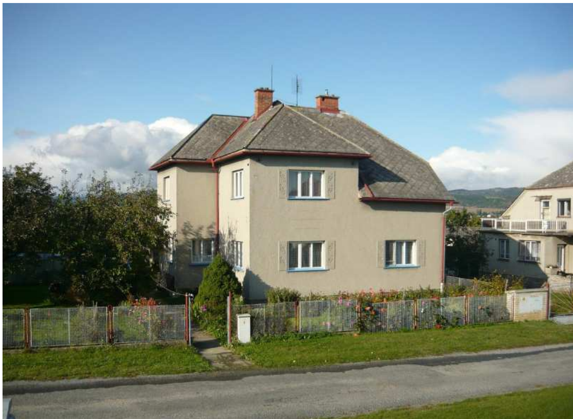
Obrázek 7 – foto oceňovaného rodinného domu
