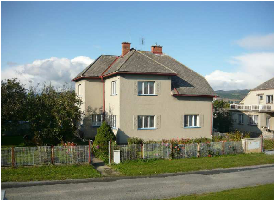
Obrázek 7 – foto oceňovaného rodinného domu
