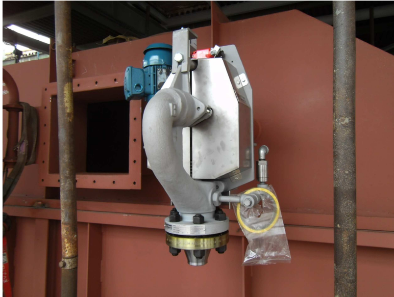
Obr. 11 Krátkovýsuvný parní ofukovač
