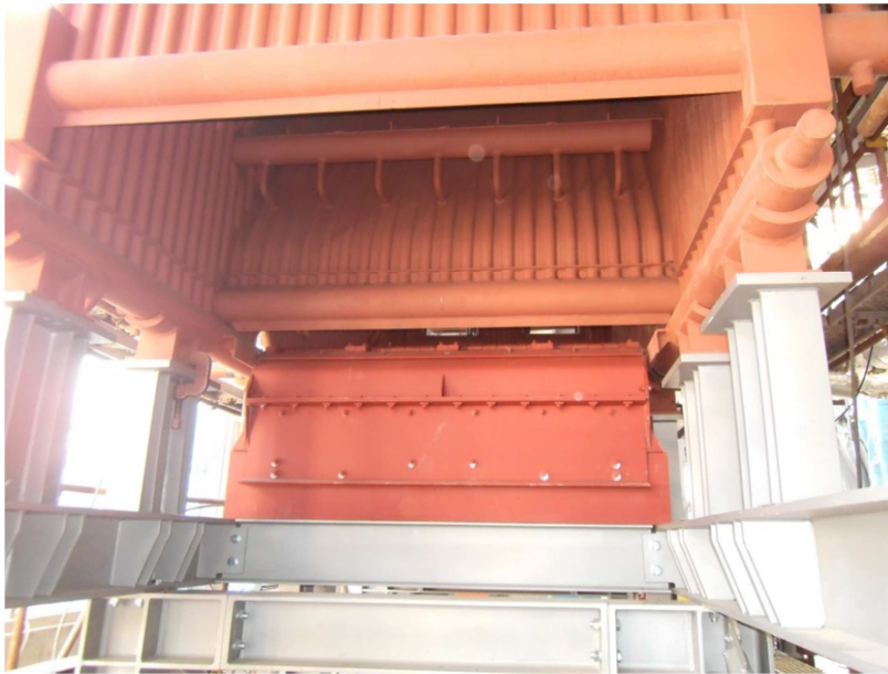
Obr. 16 Nosná konstrukce membránových stěn a roštu
