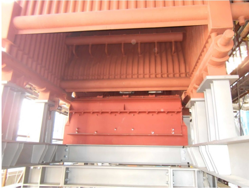
Obr. 16 Nosná konstrukce membránových stěn a roštu
