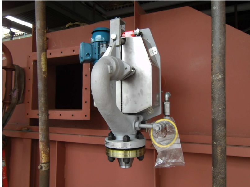
Obr. 11 Krátkovýsvný parní ofukovač
