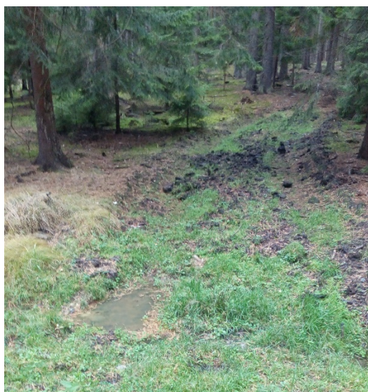
Obrázek 6 – Koleje na lesní svážnici se zemním krytem
