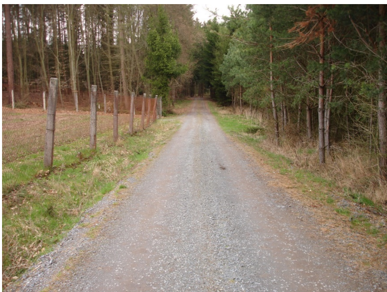
Obrázek 2 – Lesní cesta 2L s krytem z nestmeleného kameniva
