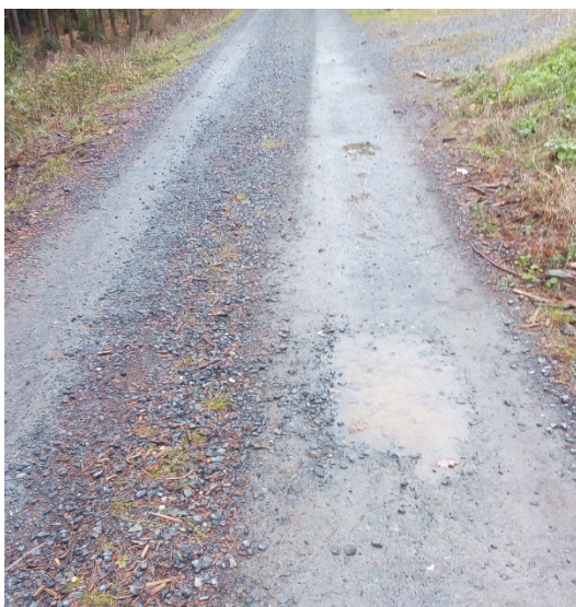
Obrázek 5 – Počínající výtluk na lesní cestě s krytem z nestmeleného kameniva
