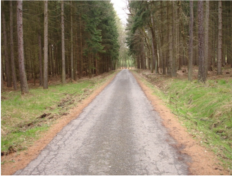
Obrázek 1 – Lesní cesta 1L s asfaltobetonovým krytem
