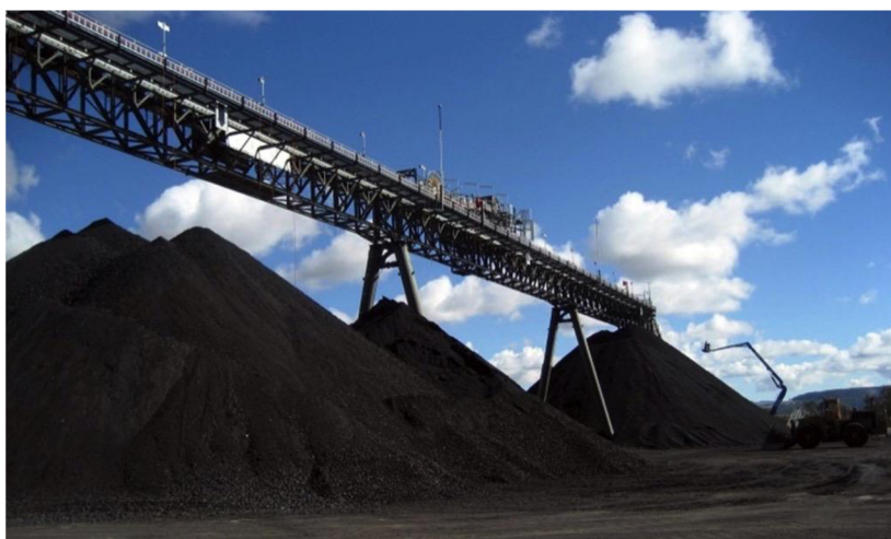
Obr. 5 Příklad nosné konstrukce pásového dopravníku
