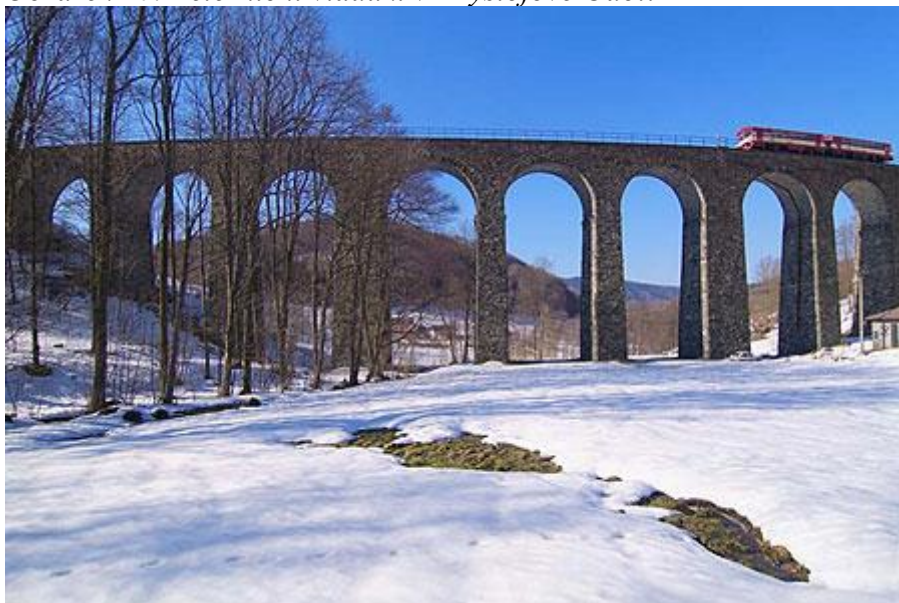
Obrázek 10: Železniční viadukt v Kryštofově Údolí
