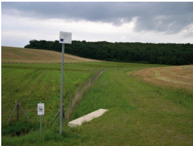
Obrázek 12 - Ochranná hrázka (zdroj: https://encyklopedie.vumop.cz/ , Hlubočany, foto VÚMOP)
