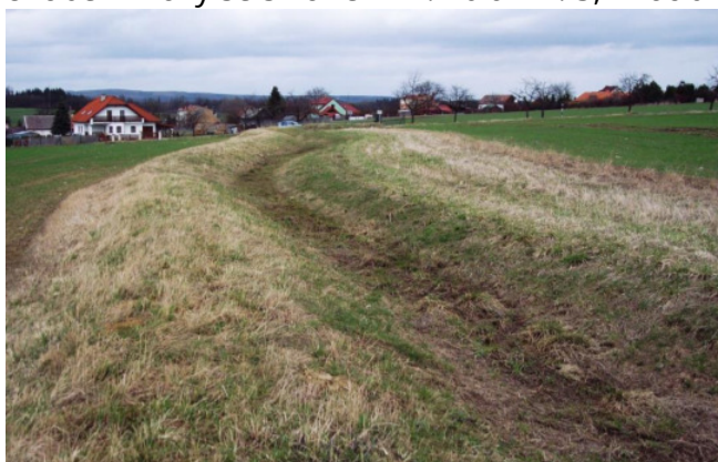
Obrázek 8 - Protierozní průleh s hrázkou v k. ú. Milínov u Nezvěstic (zdroj: KADLEC, Václav. Navrhování technických protierozních opatření)
