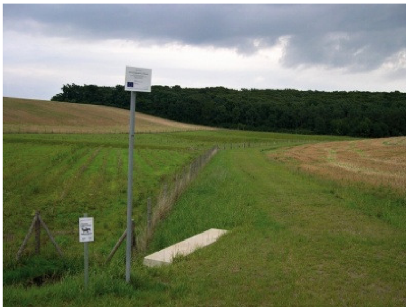
Obrázek 12 - Ochranná hrázka (zdroj: https://encyklopedie.vumop.cz/ , Hlubočany, foto VÚMOP)
