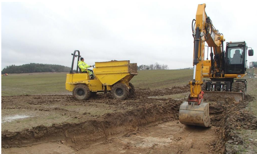
Obrázek 19 - Likvidace uniklých provozních kapalin (1)
