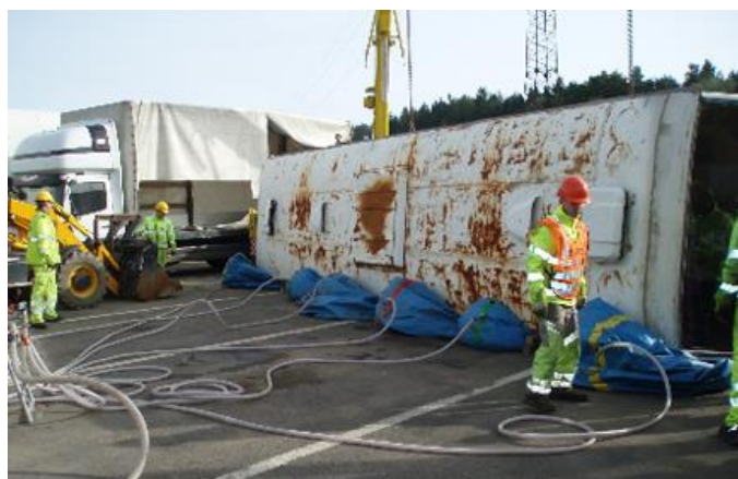
Obrázek 34 - Podsunutí nafukovacích vaků pod autobus (29)
