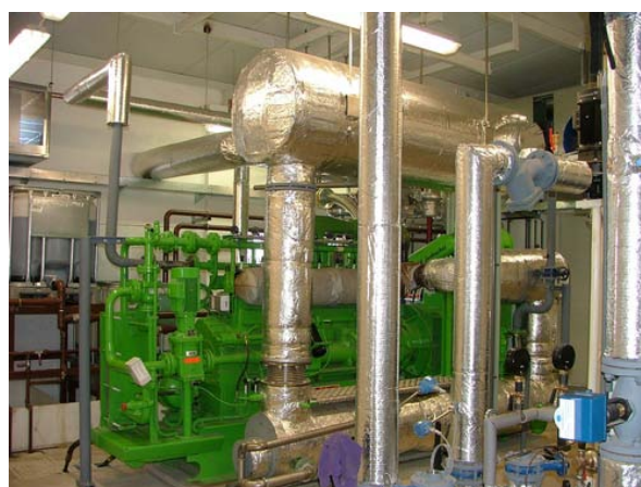
Obr. 12 – pohled na kogenerační jednotku Jenbacher JMS 208 GS
