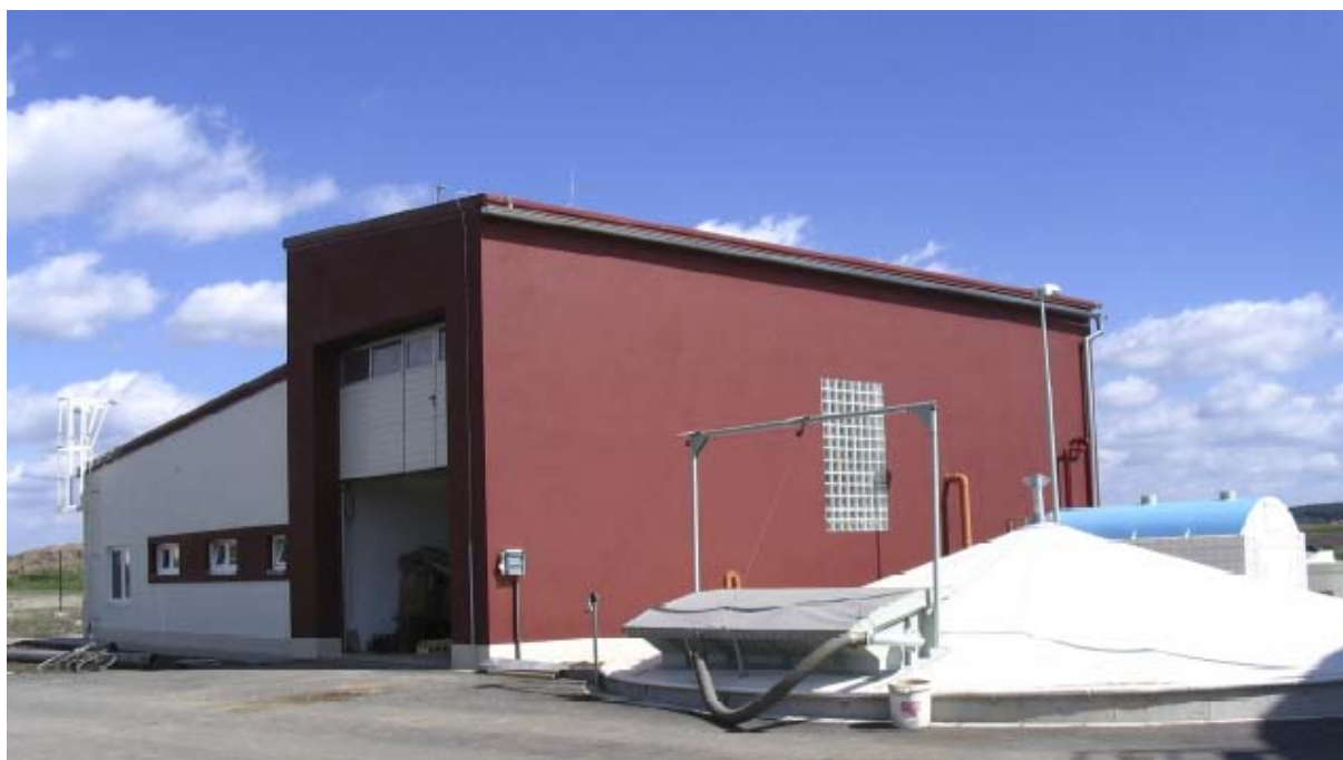
Obr. 10 - Vstupní objekt na zpracování a hygienizaci odpadů
