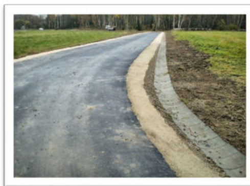
Obrázek č. 13 – Realizace příkopu HPC 19 (PÚ Karlovy Vary)
