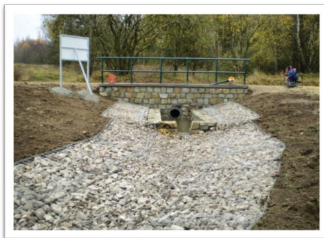
Obrázek č. 20 – Výplň drátokošů LBK 2B (Pozemkový úřad 2021)
