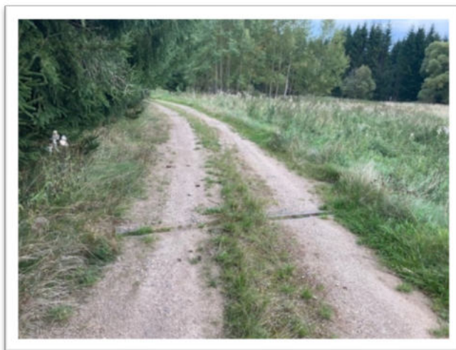
Obrázek č. 34 – Odvodnění VPC 9 (autorka)
