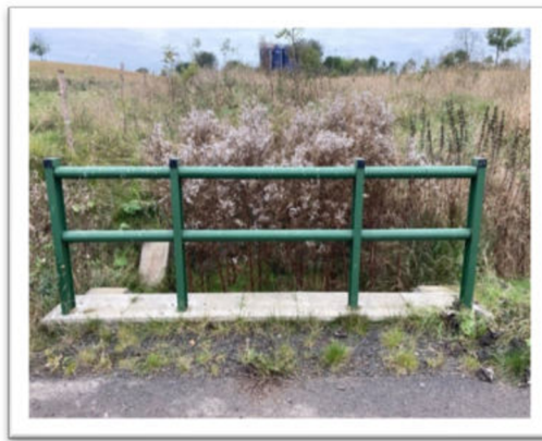
Obrázek č. 49 – Propustek HPC 3 (autorka)
