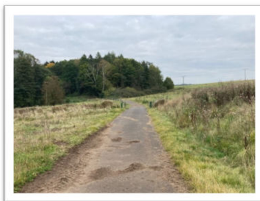
Obrázek č. 55 – VPC 6 příkop a propustek (autorka)
