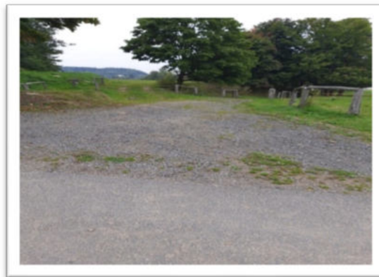
Obrázek č. 19 – VPC 8 zpevněná plocha z kamenné prosívky (autorka)
