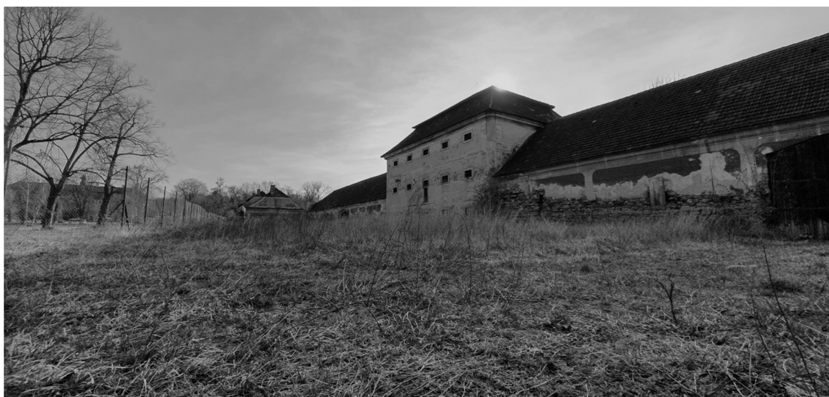
Obr. č. 3: Jihozápadní pohled na objekt stodoly se sýpkou v Měšicích (levé křídlo hospodářského dvora) (autor Filsaková 2020).
