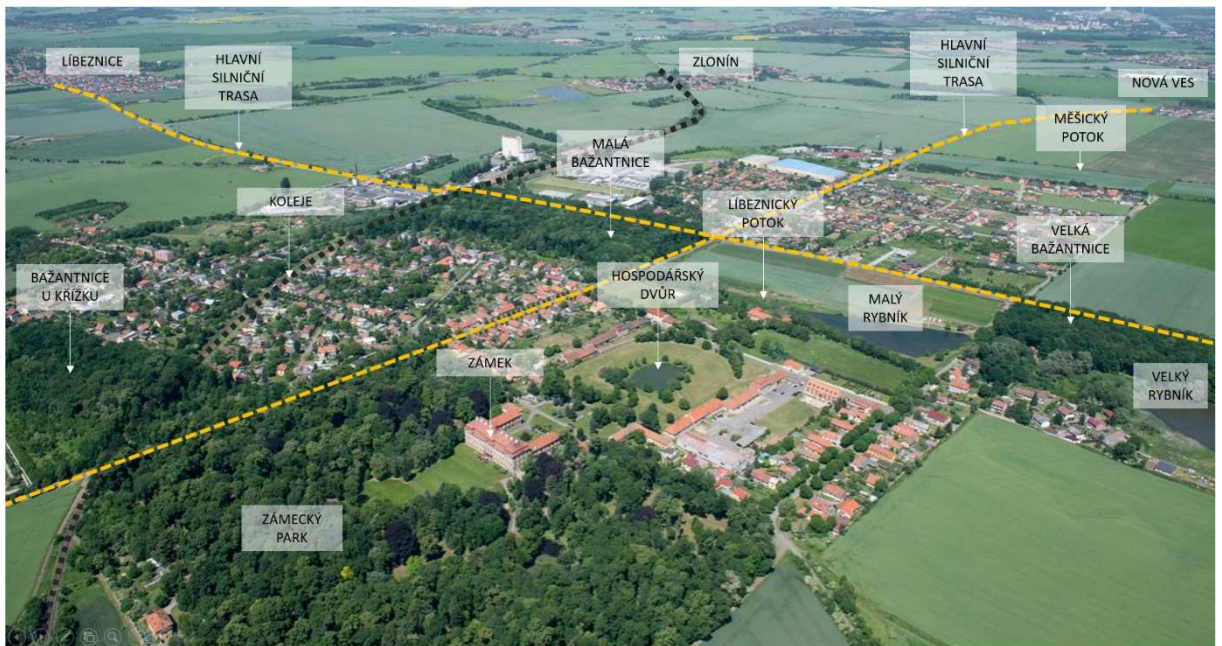
Obr. č. 12: Letecký snímek – severozápadní pohled (obec Měšice) úpravy Filsaková (2020).
