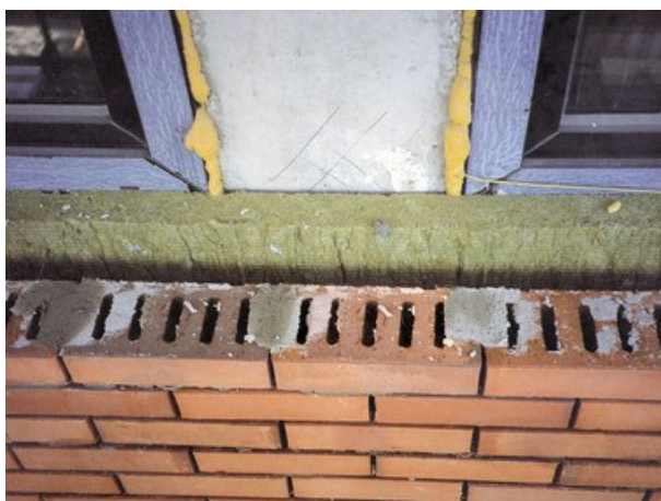
Obr. 7 Zateplení fasády s přízdívkou z cihelného zdiva
