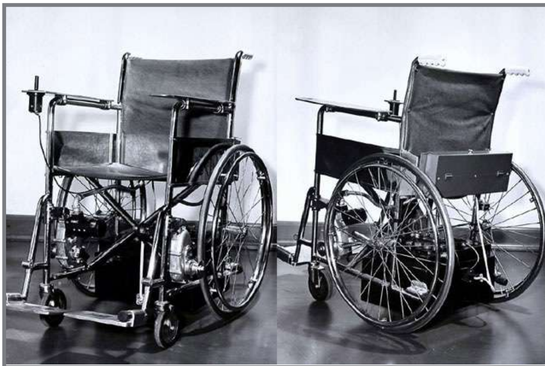
Obr. 2-18 První konstrukce mechanického vozíku z roku 1932 [18]
