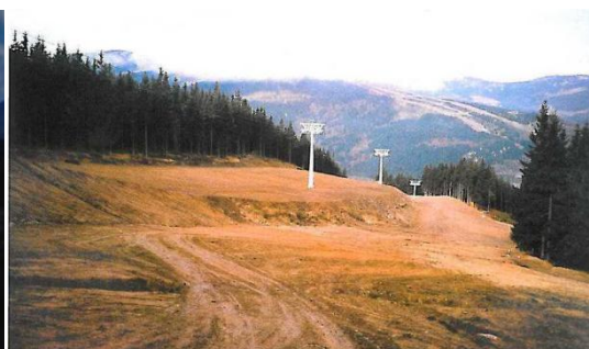
Obr. č. 5: Budování lyžařské infrastruktury
