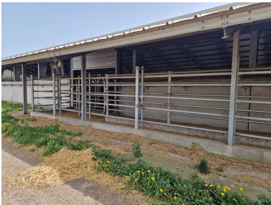
Obrázek 9: Vyskladňovací ulička vedoucí k nakládací rampě
