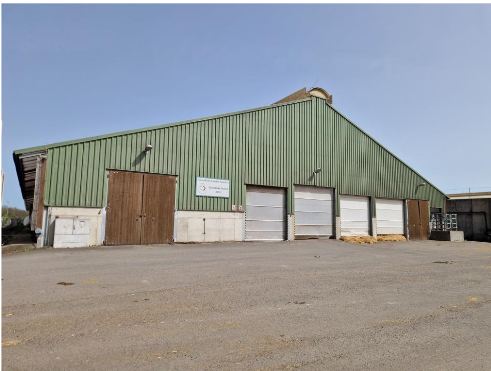
Obrázek 4: Budova odchovny mladých jalovic
