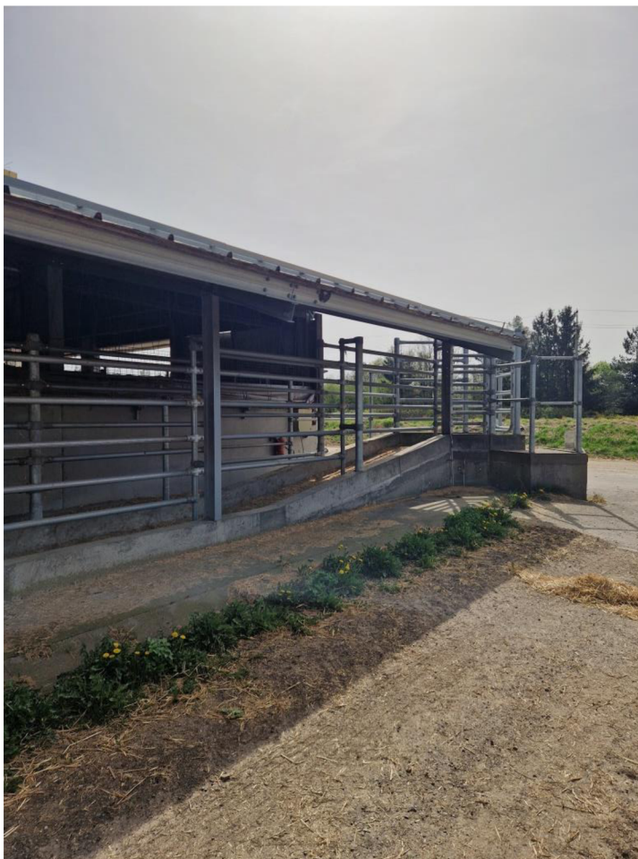
Obrázek 8: Nakládací rampa pro usnadnění nakládání na kamión
