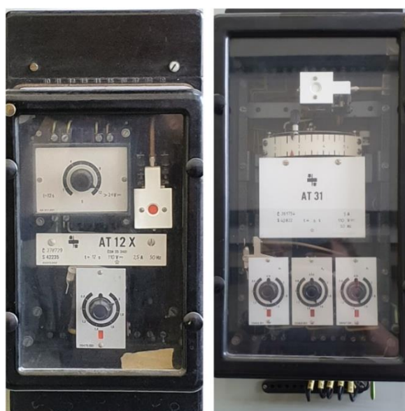
Obrázek 6 Nadproudové ochrany A 12 X a AT 31
