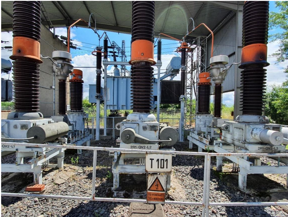
Obrázek 14 PTP na straně 110 kV
