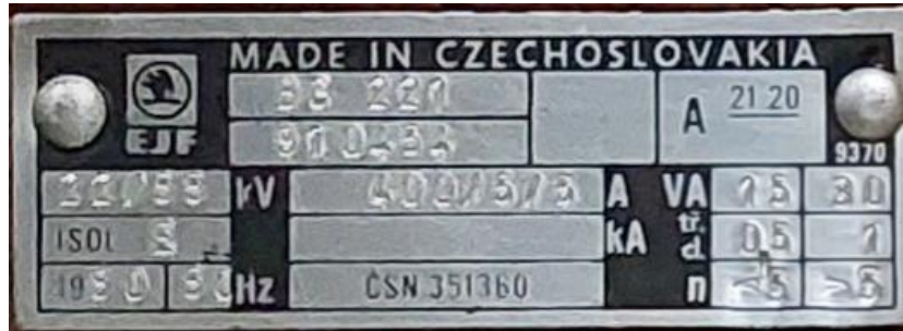
Obrázek 15 Štítkové parametry PTP na straně 22 kV
