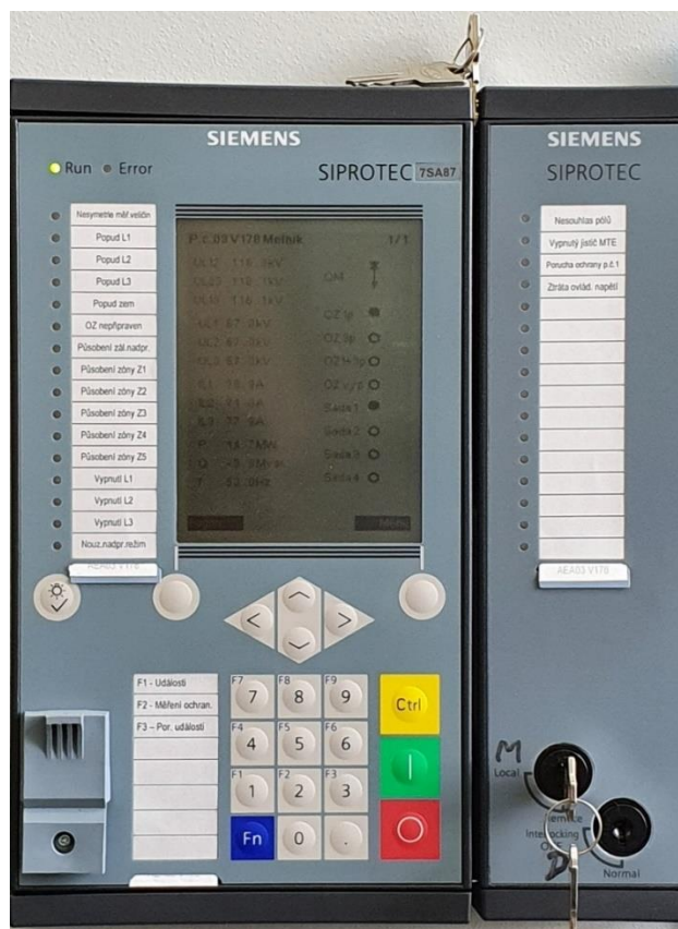
Obrázek 7 Distanční ochrana SIPROTEC 7SA87
